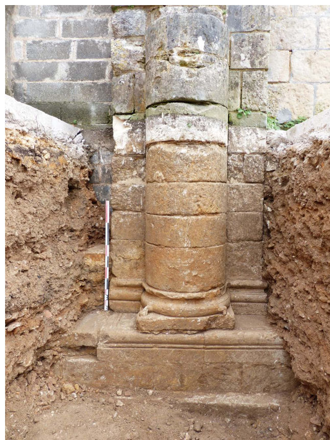
SAINTES, église Saint-Eutrope, fig. 2, sondage 17, Partie inférieure de la colonne engagée du mur gouttereau sud de la nef (Mire de 1 m) (cliché : Inrap)
