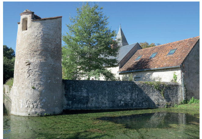
Cour-Cheverny (Loir-et-Cher) 25 chemin de La Crépinnière : tour d'angle flanquant le mur d'enceinte du domaine, avec les douves au premier plan (Gwenaël Roy, Inrap).
