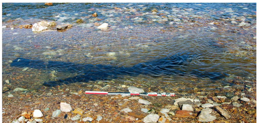
Blois (Loir-et-Cher) pile 2 du pont antique 049AH : moises entrecroisées assemblées à mi-bois (Didier Josset, Inrap).
