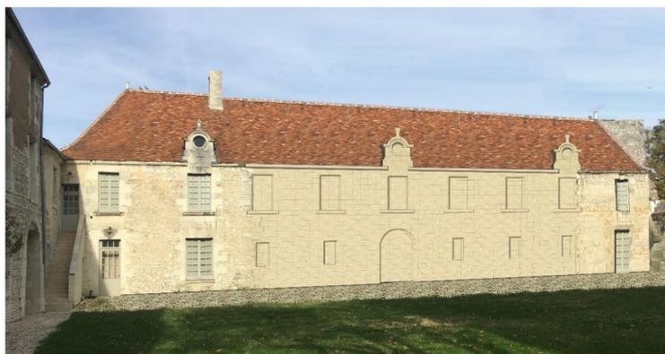
Pour ce faire, la façade principale sur cour sera rétablie en pierre de taille massive en évoquant par des défoncés l'emplacement des anciennes ouvertures.
