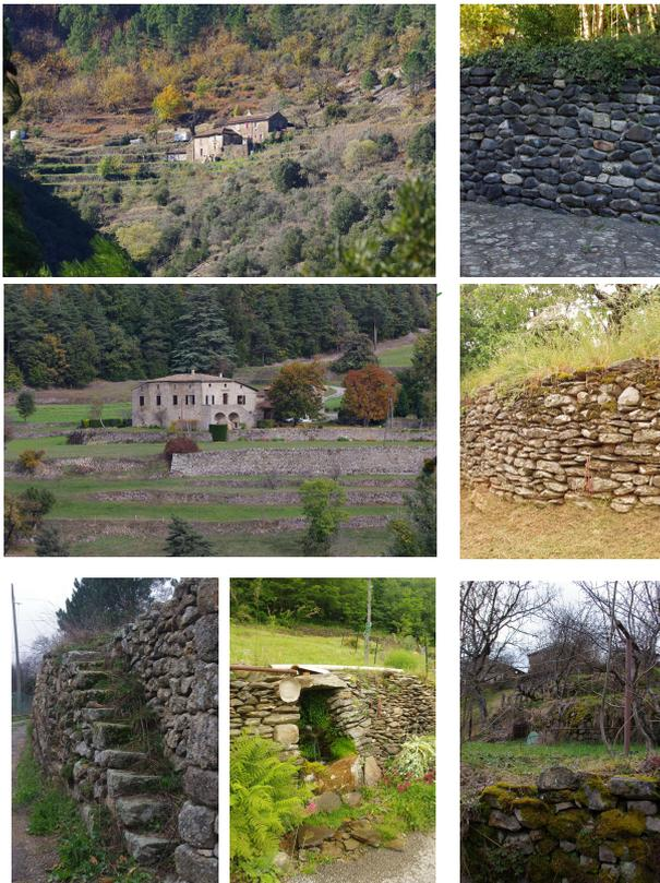
Mur de soutènement en pierres sèches – avec escalier et fontaine
