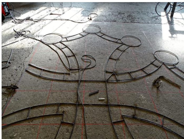
Ill. 1. Construction d'une structure en fer, la croix occitane, pour le char de la région Occitanie. © Mathilde Lamothe, 10 février 2020.
