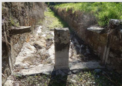
Glissières de martelières en pierres ©EICC, octobre 2023
