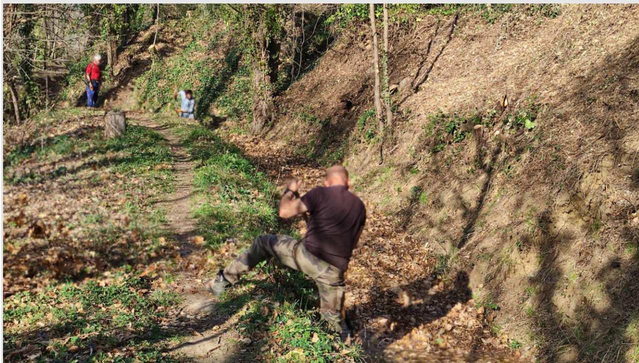
Curage d'un canal avant sa remise en eau © JYQ , 28/02/2022
