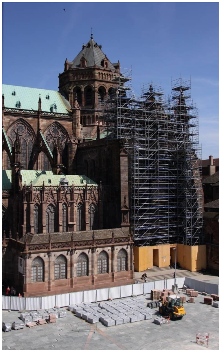
Chantier actuel de la cathédrale, avec un échafaudage installé devant le bras sud du transept (2013). Crédits : Fondation de l'Œuvre Notre-Dame, Strasbourg
