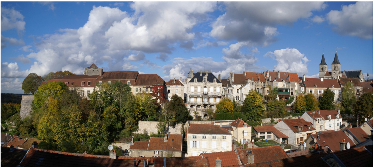
Vue panoramique du centre-ville de Chaumont, du donjon du château des comtes de Champagne à la basilique Saint-Jean-Baptiste. © Pascal Michaut, 2017.
