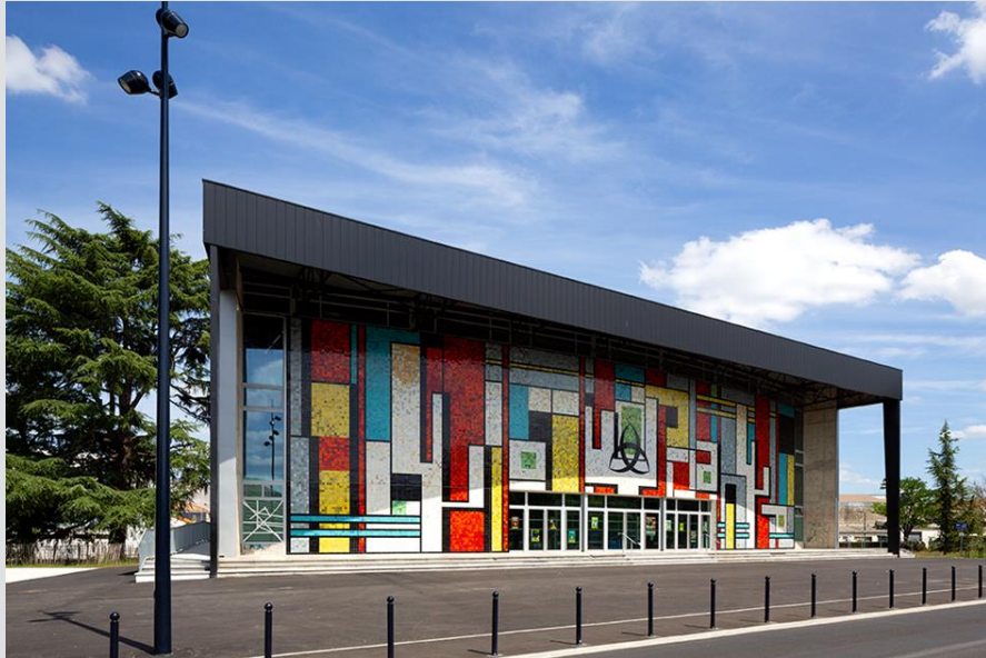
Salle des fêtes du Grand Parc Bordeaux (33), Nouvelle-Aquitaine Claude Ferret, Robert Bedout, Serge Bottarelli, architectes, 1964 © D.R.
