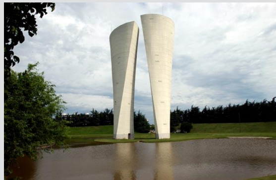
Château d'eau de Valence Valence (26) André Gomis, architecte ; Philolaos Tloupas, sculpteur 1963-1971 © Drac Auvergne-Rhône-Alpes
