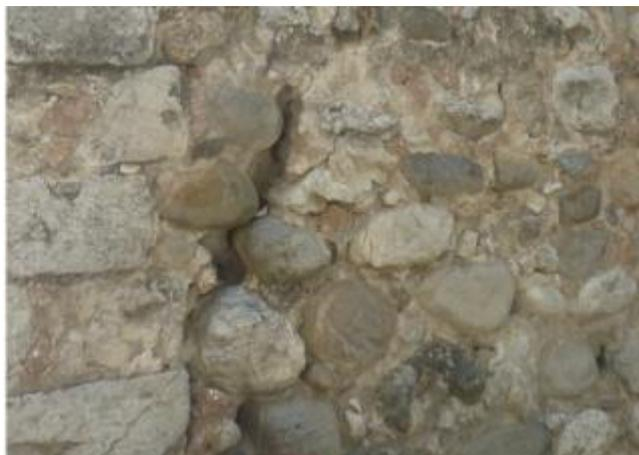
*Vues de mise en œuvre en soubassement des galets pris dans les alluvions fluviales entourant le village.*
