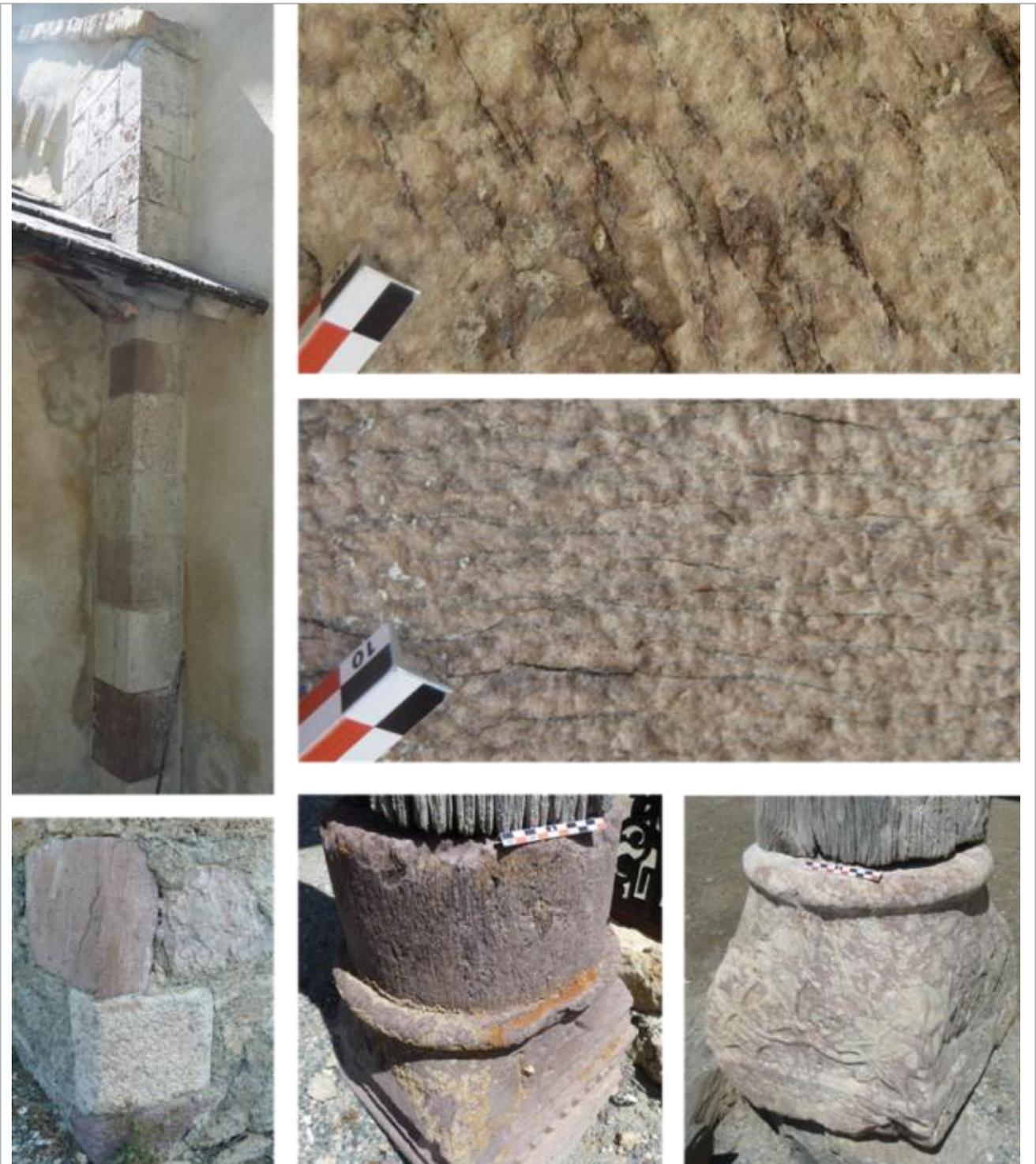
*Vues de mise en œuvre des calcaires noduleux colorés « Marbres de Guillestre s.l. ».*
