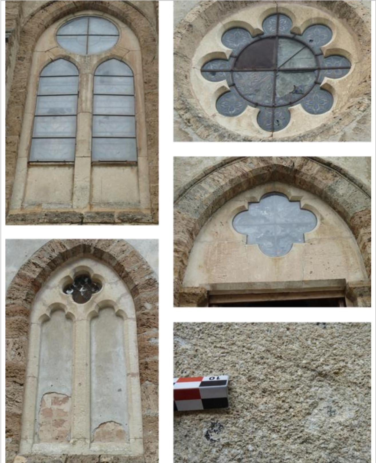
*Vues des éléments (restauration 20<sup>ème</sup> ?) en calcaire biodétritique tendre, beige, à grain fin homogène « Molasse du Midi ».*
