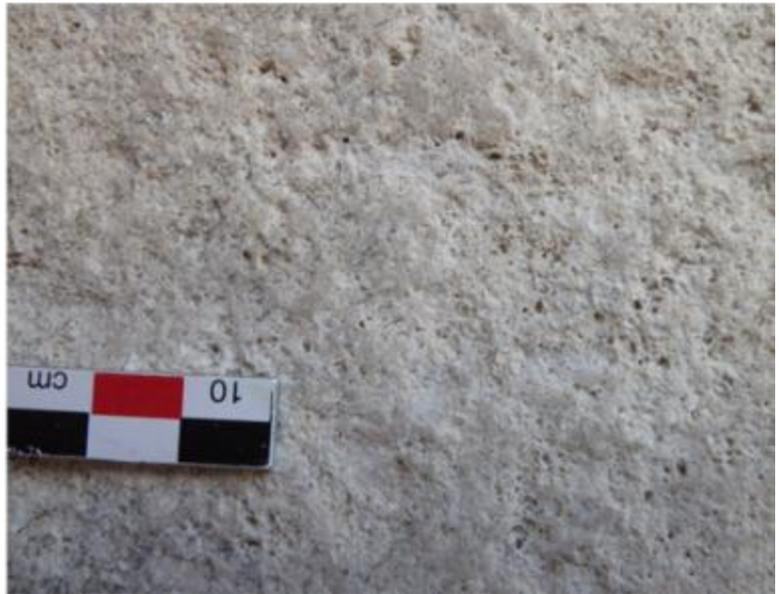
*Vues de mise en œuvre du calcaire beige-crème, à grain fin et fines perforations.*
