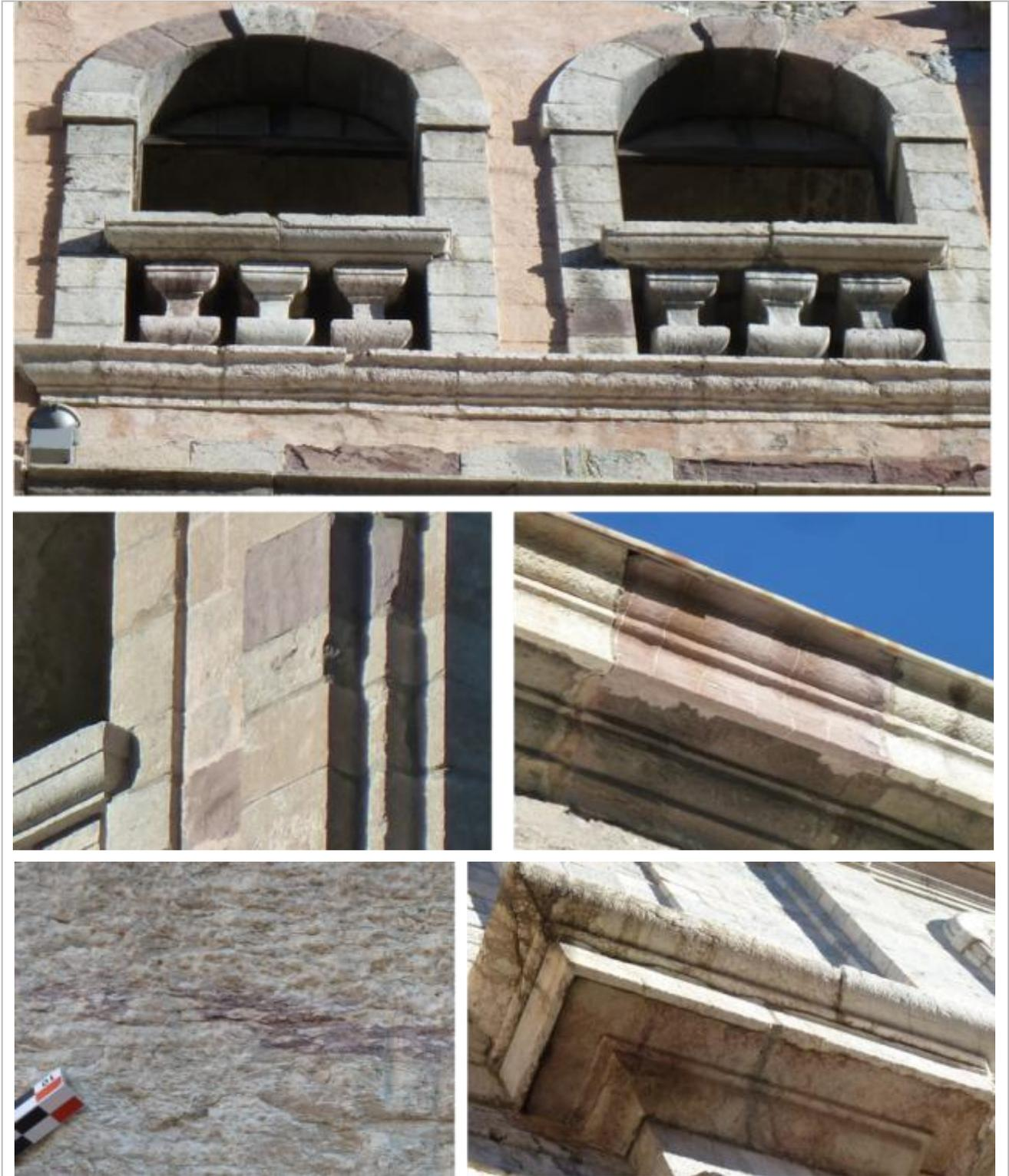
*Vues de mise en œuvre des blocs épars de calcaire violacé.*
