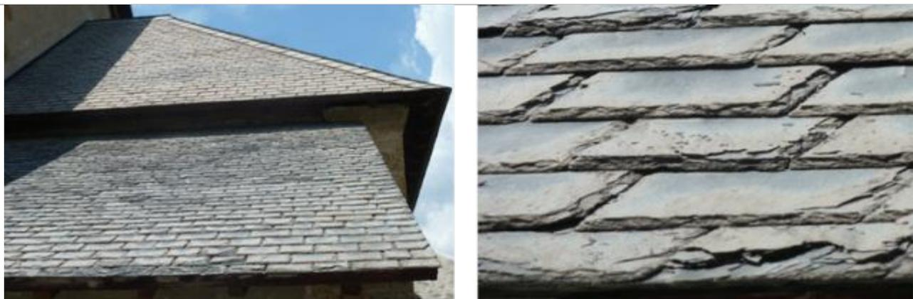
*Vue de la toiture couverture de schiste ardoisier.*
