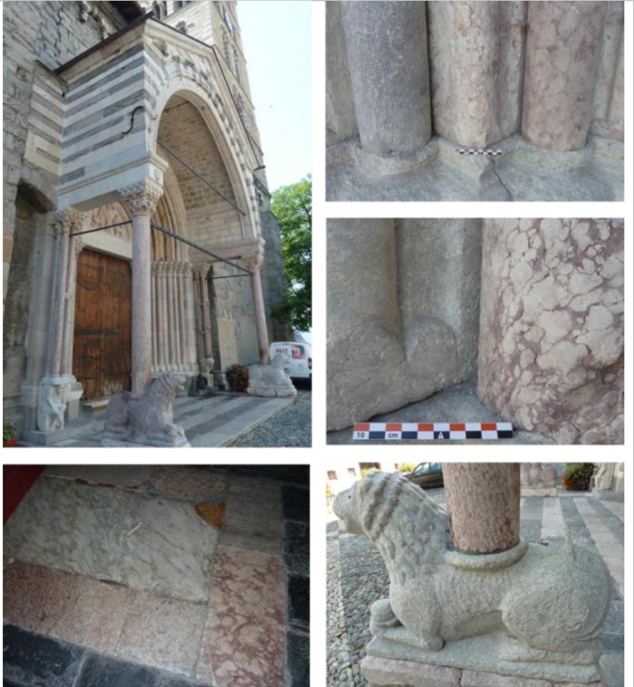
*Vues de mise en œuvre des calcaires noduleux de teintes diverses (marbres de Guillestre s.l.).*
