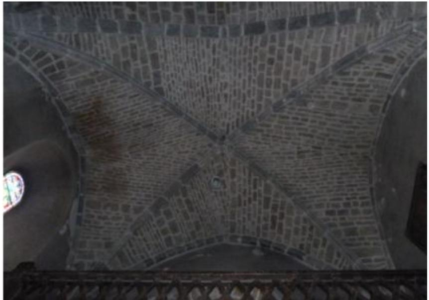
*Vues de mises en œuvre intérieures du calcaire marbrier gris « Portor Briançonnais » en piliers et arcatures des voutes et du Tuf de Monétier en remplissage des voutes.*
