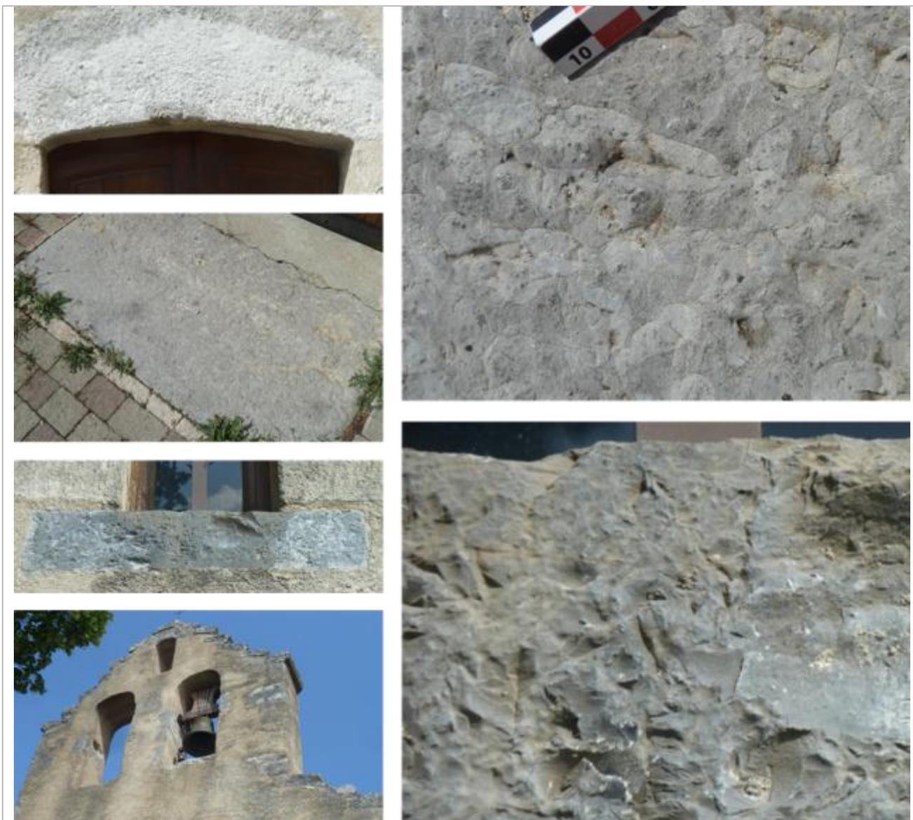
*Vues des mises en œuvre du calcaire compact gris, pseudoconglomératique intraformationnel.*
