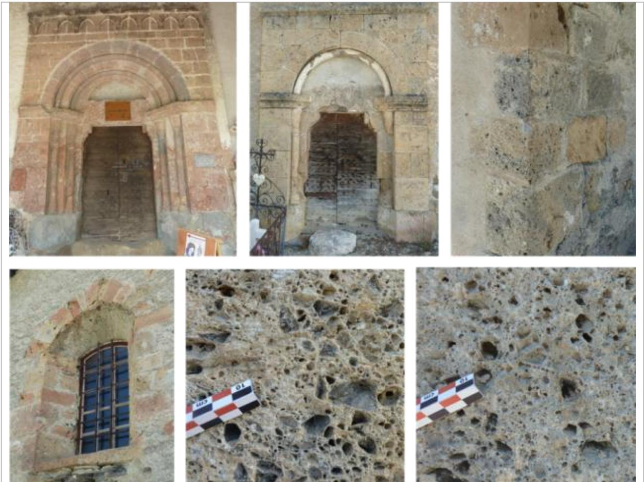
*Vues de mise en œuvre des cargneules jaunâtre à grisâtre.*
