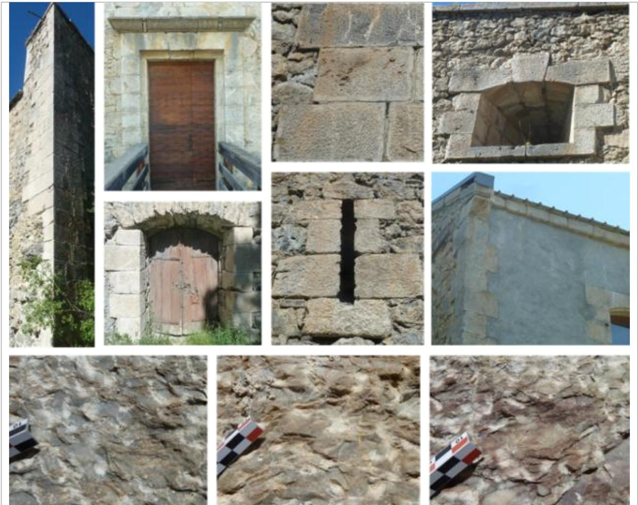
*Vues de mise en œuvre du calcaire fin massif gris et du calcaire cristallin amygdalaire gris-clair à gris-verdâtre à nuances rosées, entrecoupés de veines blanches de calcite.*
