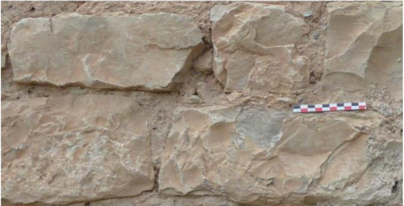
*Vues de mise en œuvre des moellons roulés ou éclatés de calcaire à pâte fine, à cassure gris-clair et patine rose-orangée (Pierre de Montmaur).*
