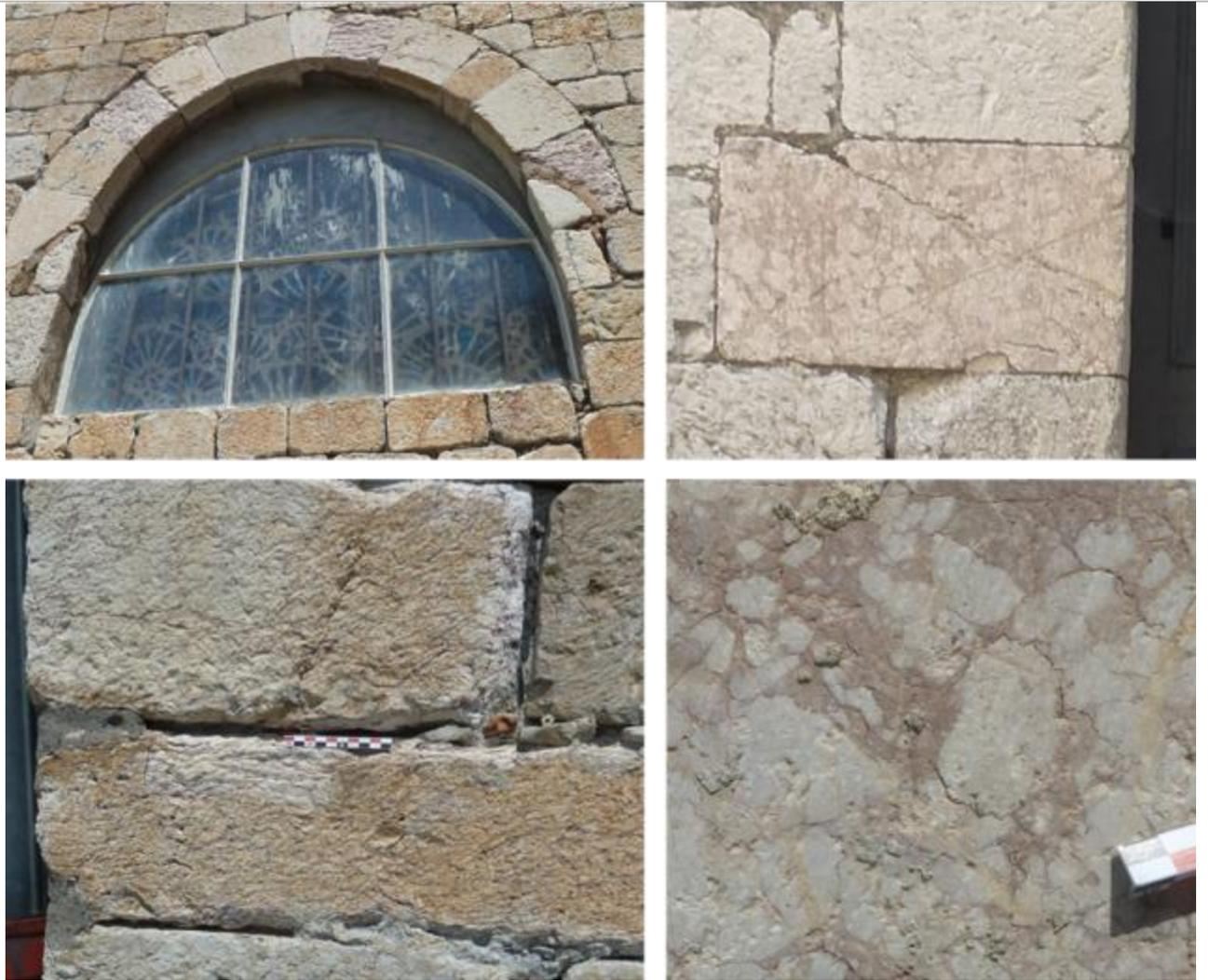
*Vues de mise en œuvre du calcaire noduleux à fond rosé et éléments beiges (Marbre de Guillestre s.l.).*
