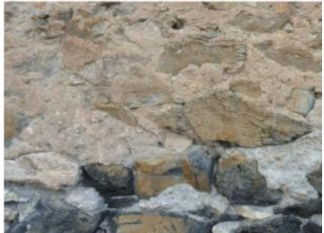
*Vues de mise en œuvre des galets roulés de natures diverses et des moellons bruts de calcaire grés-argileux noirâtre.*
