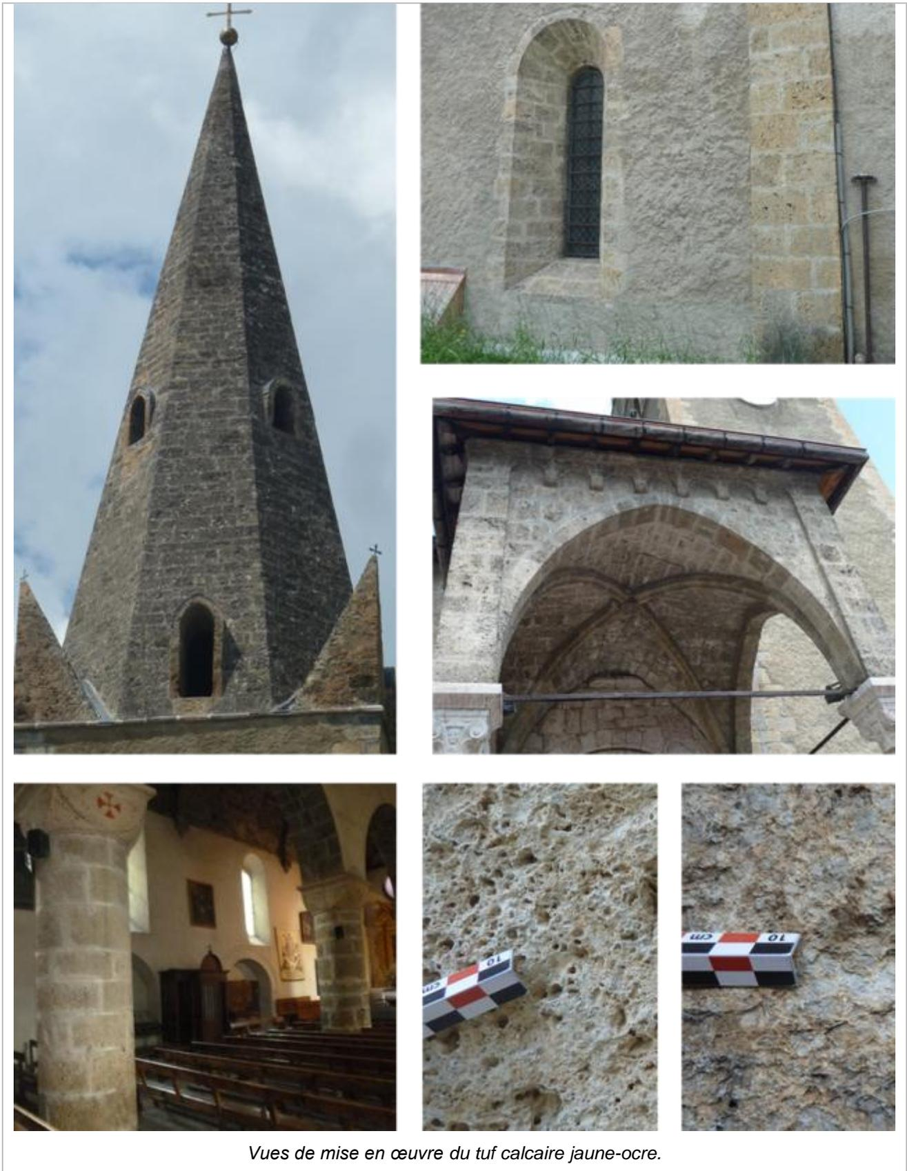
*Vues de mise en œuvre du tuf calcaire jaune-ocre.*
