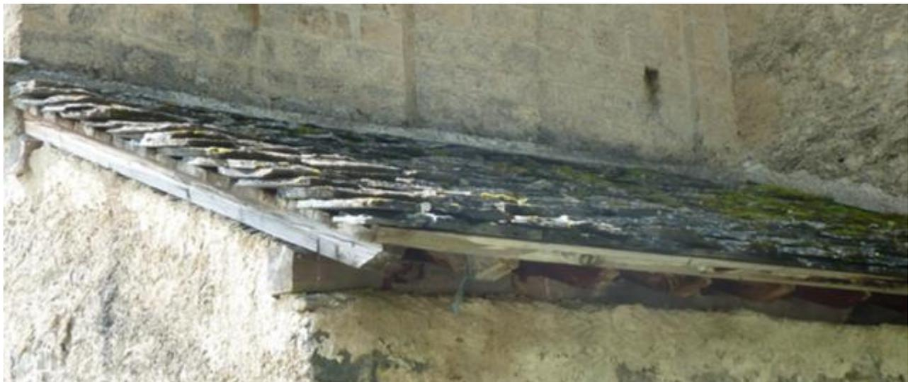
*Vue de mise en œuvre des ardoises épaisses grisâtres en couverture du collatéral nord.*
