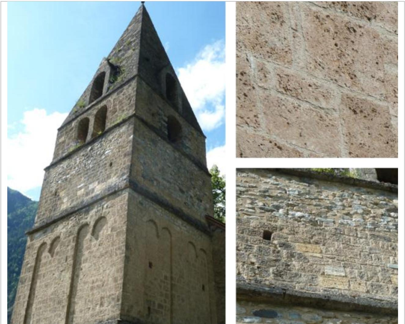
*Vues de mise en œuvre au niveau du clocher des blocs taillés de petit appareil en cargneule jaunâtre plus ou moins vacuolaire (« tuf »).*
