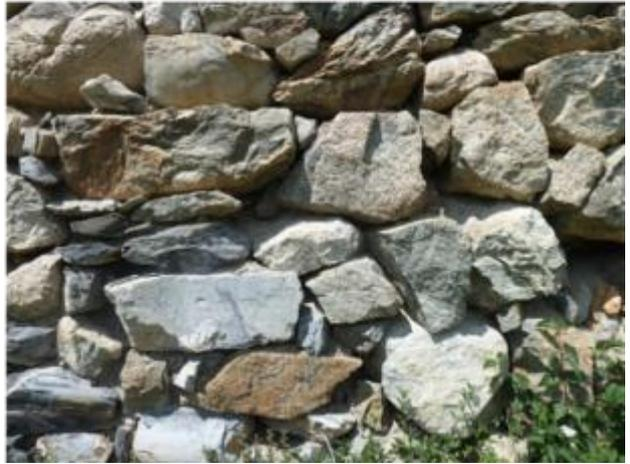
*Vues de la maçonnerie de moellons bruts et remplissage d'éléments de plus petite taille.*
