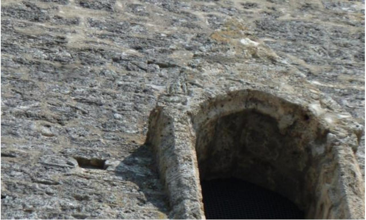
*Vues de mise en oeuvre de la cargneule « Tuf de Crots ».*
