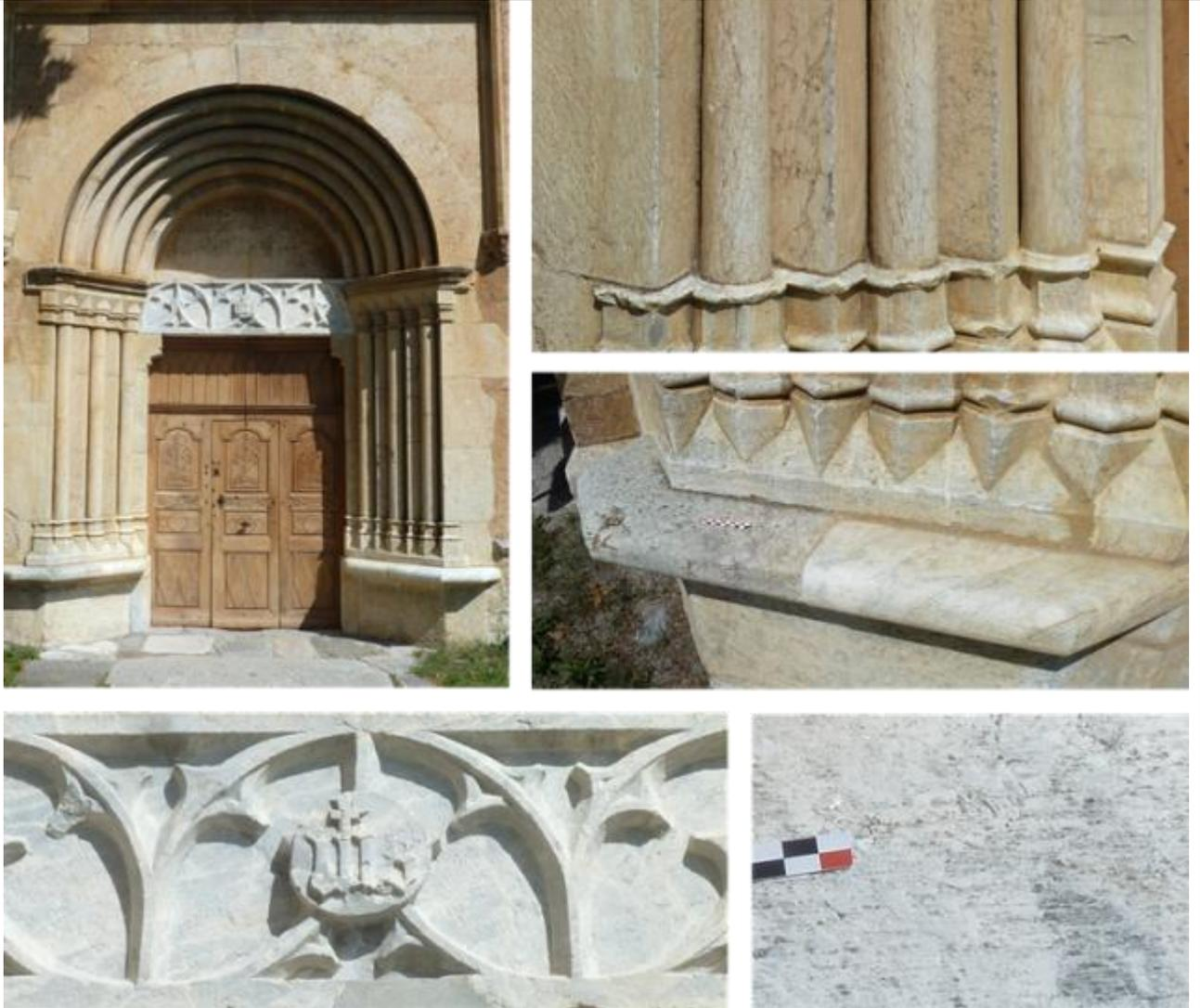
*Vues du portail : mise en œuvre majoritaire des calcaires noduleux rose-violacé à blanc-verdâtre « Marbre de Guillestre s.l. » sauf linteau en calcaire marbrier gris entrecoupé de veines blanches de calcite et certains éléments de margelle en calcaire cristallin blanc à passées éparses grises (restauration ?).*
