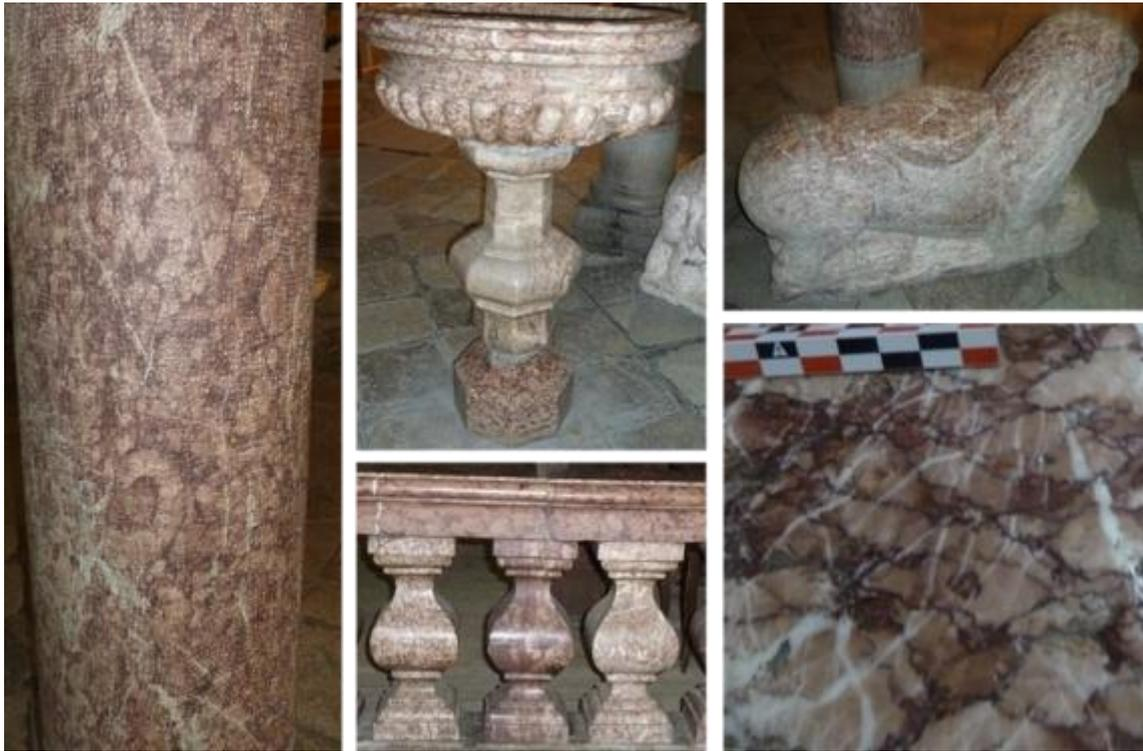
*Vues de mise en œuvre du calcaire noduleux à fond rouge-brun et éléments beiges, plus ou moins entrecoupé de veines blanches de calcite.*
