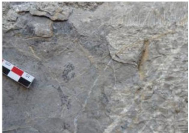
*Vues de mise en œuvre du calcaire à pâte fine de teinte gris-bleu à veines blanches de calcite.*
