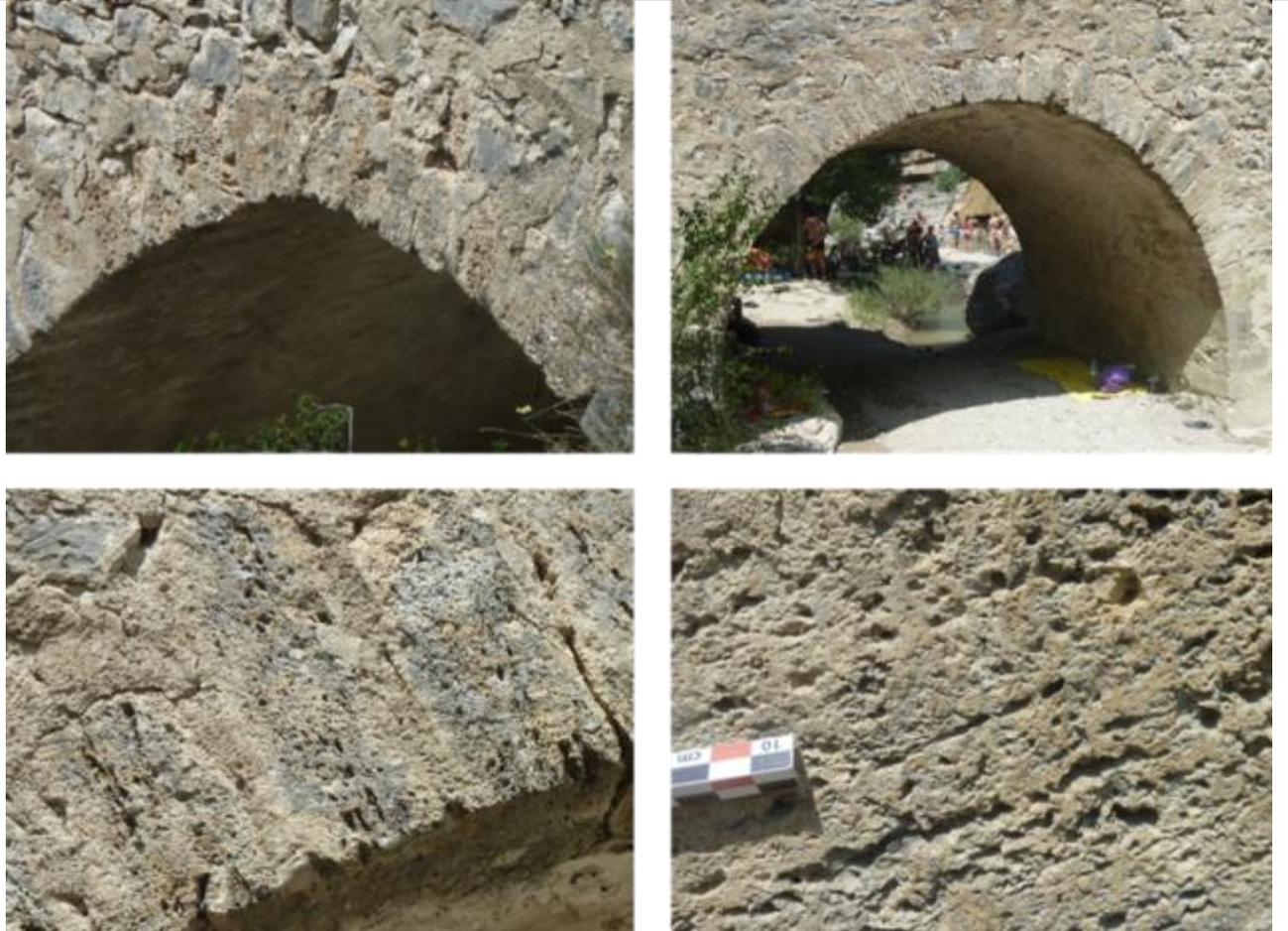
*Vues de mise en œuvre du travertin (tuf calcaire) jaunâtre, finement vacuolaire et légèrement lité.*
