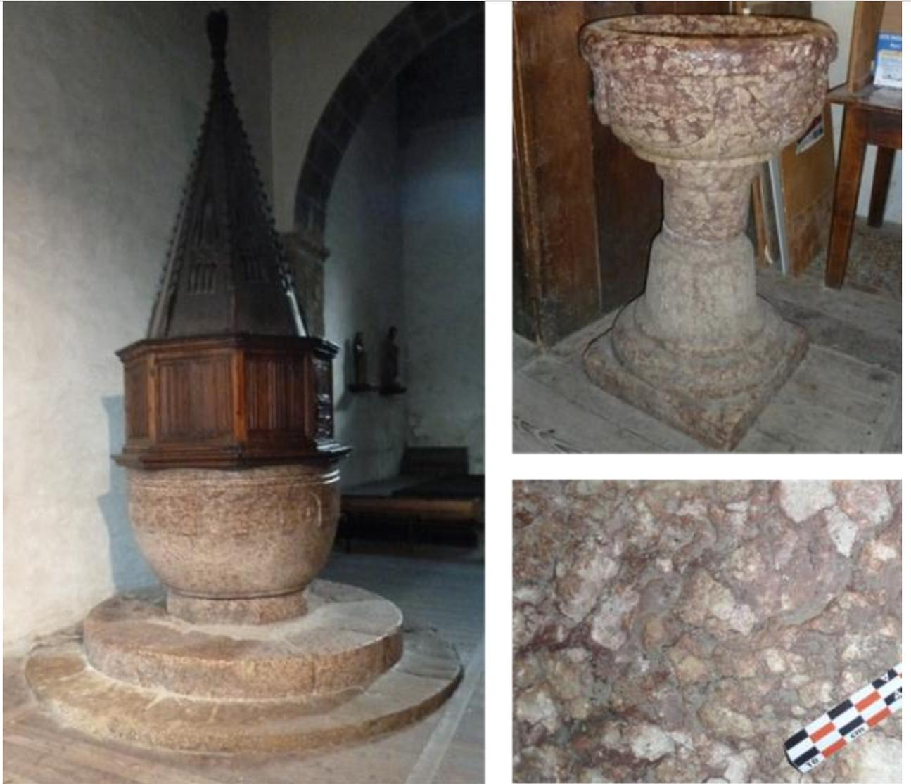
*Vues de mise en œuvre intérieure du calcaire noduleux rose-violacé « Marbre de Guillestre s.l. ».*
