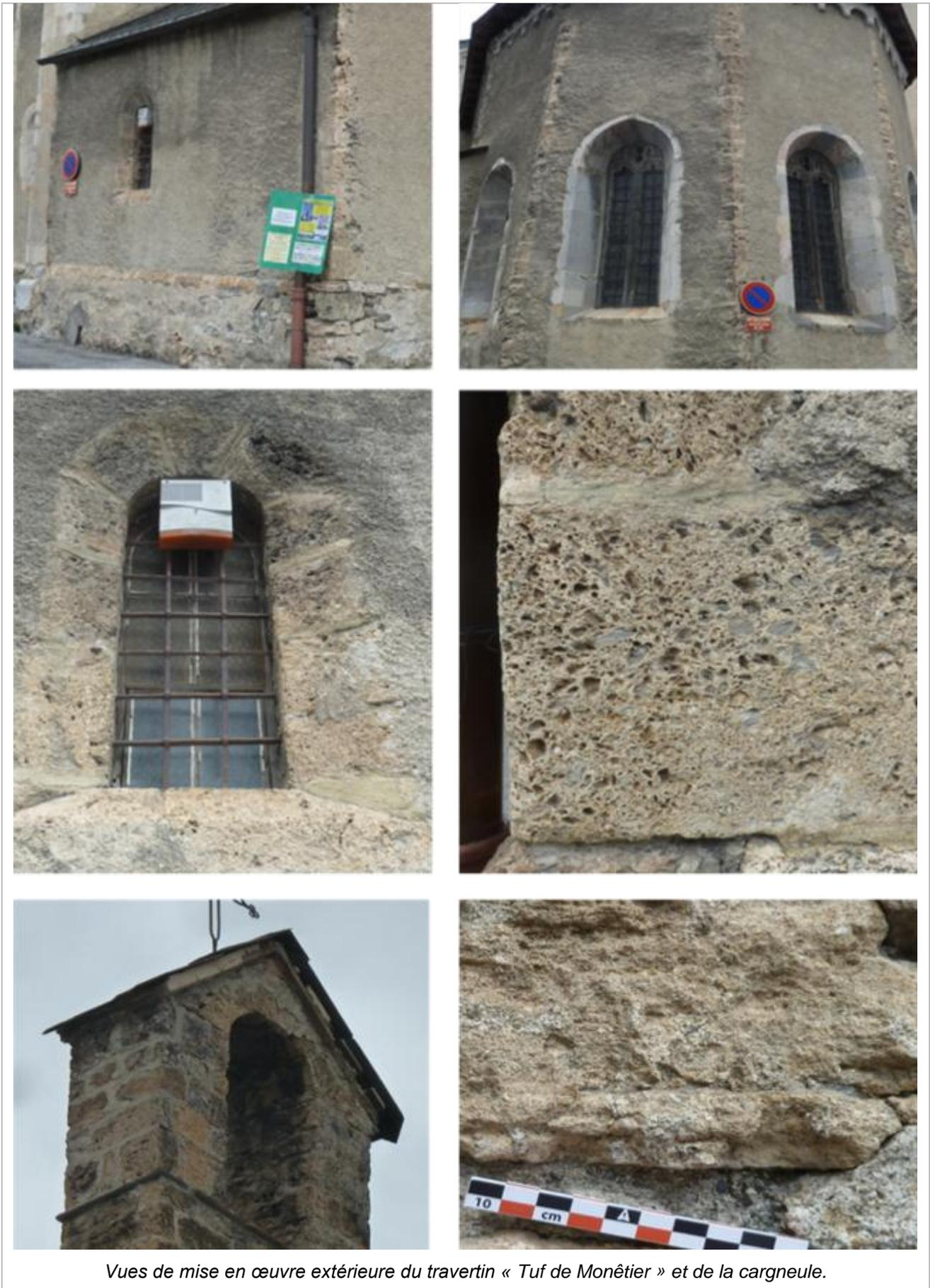
*Vues de mise en œuvre extérieure du travertin « Tuf de Monétier » et de la cargneule.*
