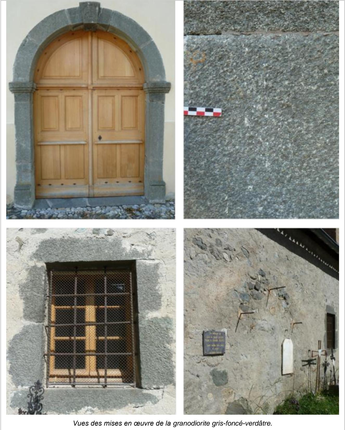
*Vues des mises en œuvre de la granodiorite gris-foncé-verdâtre.*
