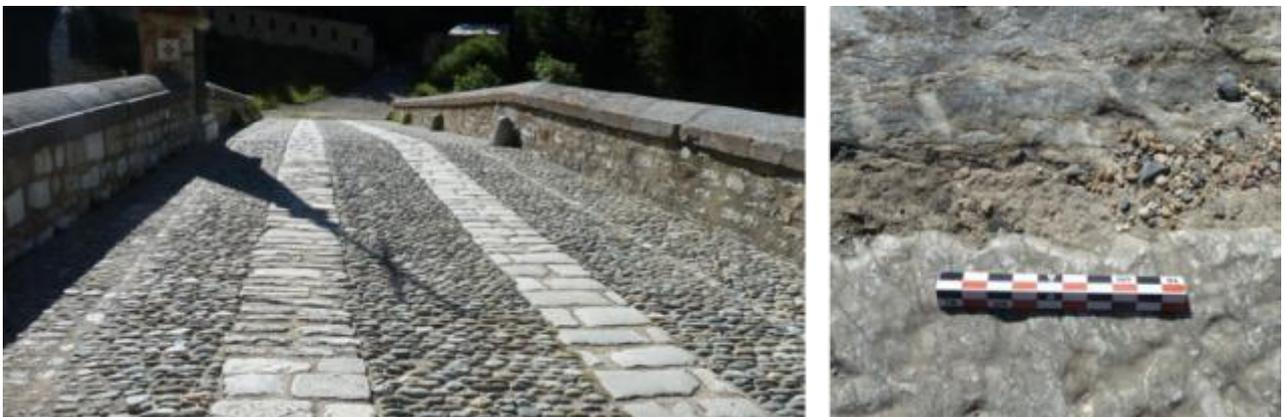
*Vues des calcaires et galets constituant la bande de roulement du pont.*
