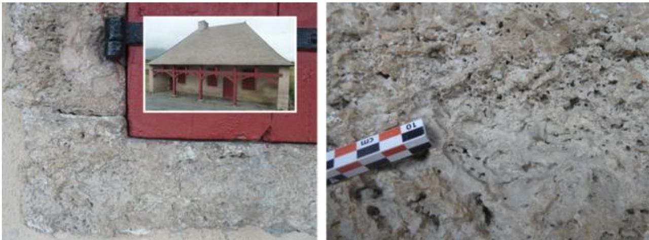
*Vues de mise en œuvre du travertin (tuf calcaire) à patine beigeâtre (badigeon ?) provenant de Risoul.*
