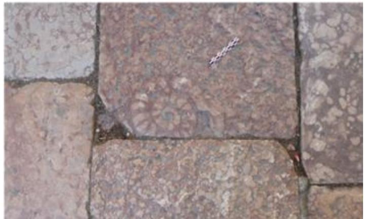
*Vues de mise en œuvre intérieure des calcaires noduleux « marbre de Guillestre ».*
