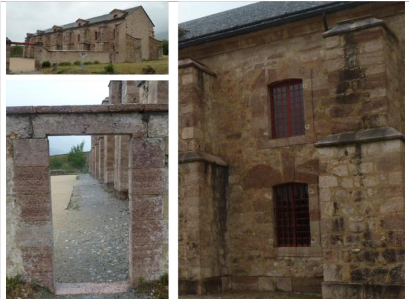
*Vues de mise en œuvre des calcaires noduleux à fond violacé et éléments beige-rosés (Marbre de Guillestre s.l.) dans l'Arsenal.*
