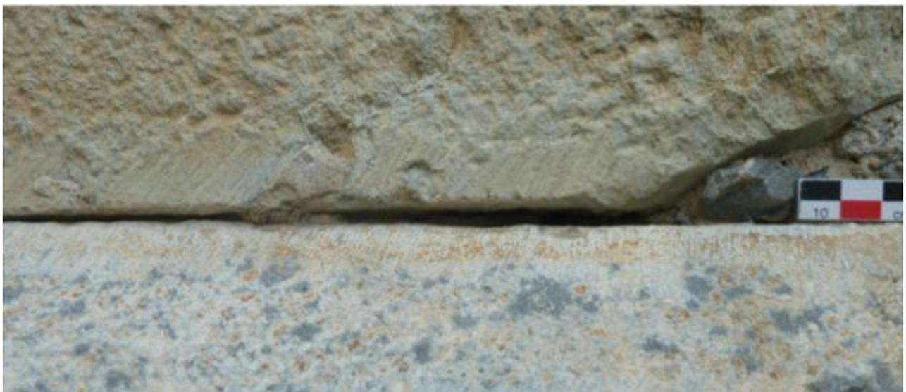
*Vues de mise en œuvre du calcaire rubané gris-sombre en mélange avec le calcaire fin vert-céladon.*
