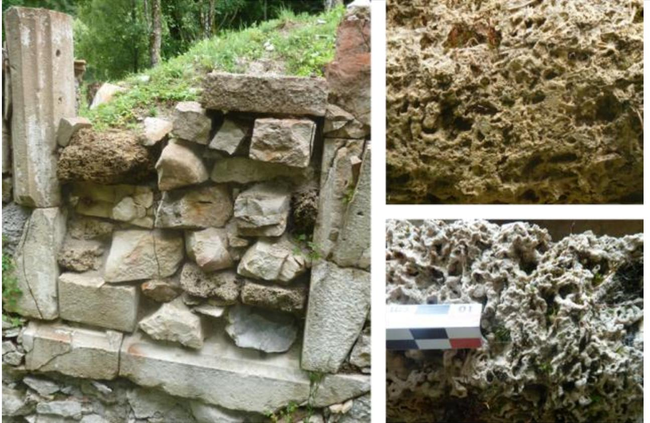
*Vues des moellons de tuf calcaire beigeâtre à brunâtre.*
