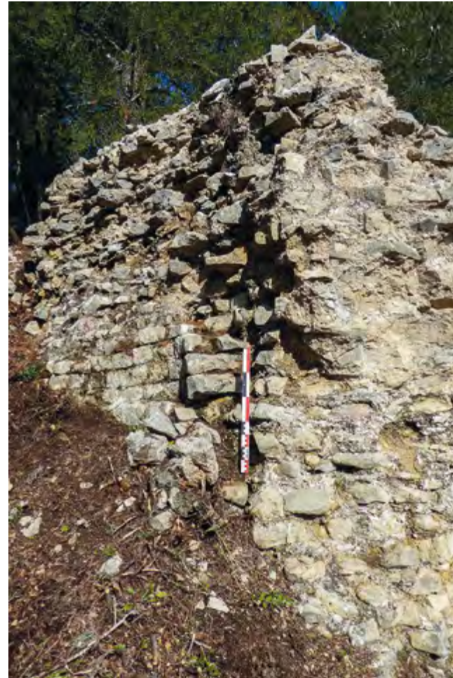
Fig. 106 – MEYRARGUES, Aqueduc de Traconnade – Sentier du Patrimoine. Portion du mur bahut (OIP n° 2) au nord des piles du Pas de l'Étroit (cliché A. Coutelas/ArkeMine SARL).
