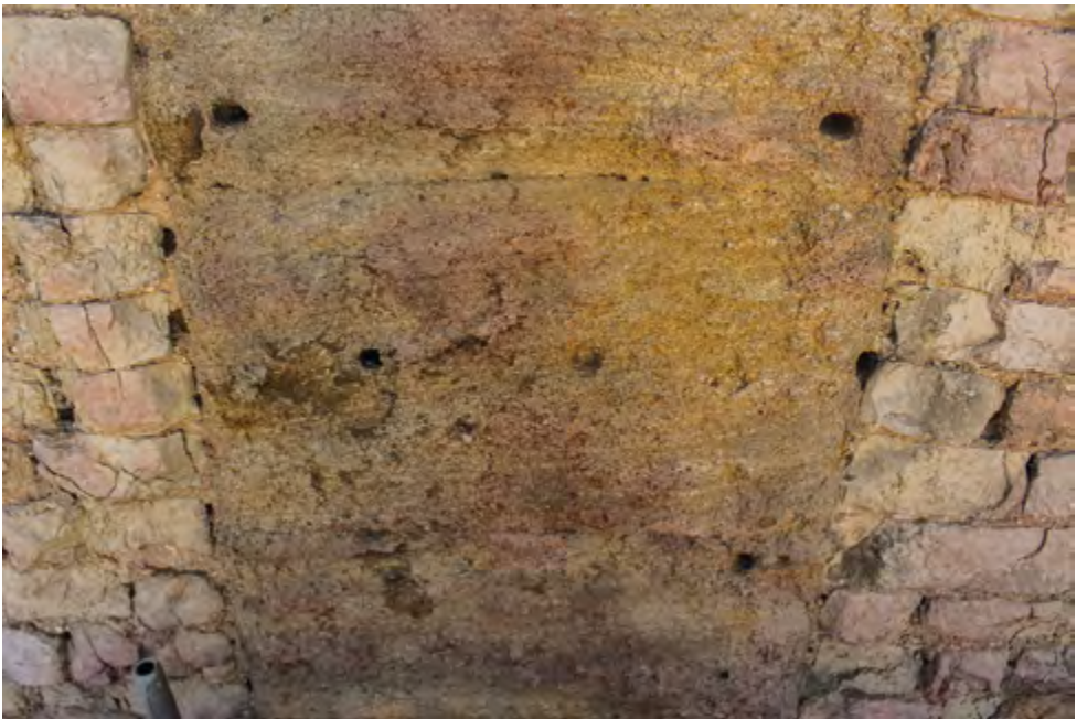
Fig. 179 – ORANGE, Mur Pontillac. Vue de plusieurs mortaises de fixation du décor de marbre, façade est (cliché J. Taulier).
