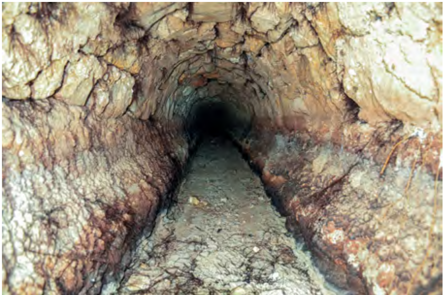
Fig. 62 – AIX-EN-PROVENCE, 7, cours de la Trinité. Vue de l'intérieur du conduit de l'aqueduc en partie colmaté par un fort concrétionnement (cliché St. Bonnet/DAMVA).
