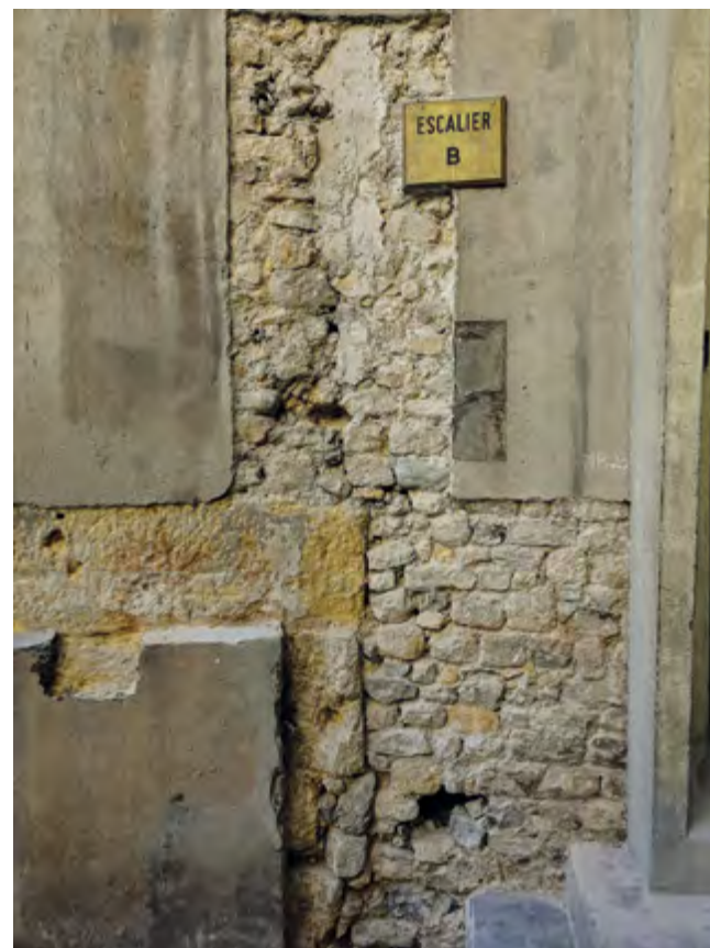
Fig. 58 – AIX-EN-PROVENCE, Immeuble Gayaud, 18 bis et 20, rue Marius Reynaud. Vestiges d'habitations antérieures aux réaménagements modernes, reconnus dans la cour nord (cliché Cl. Auburtin).
