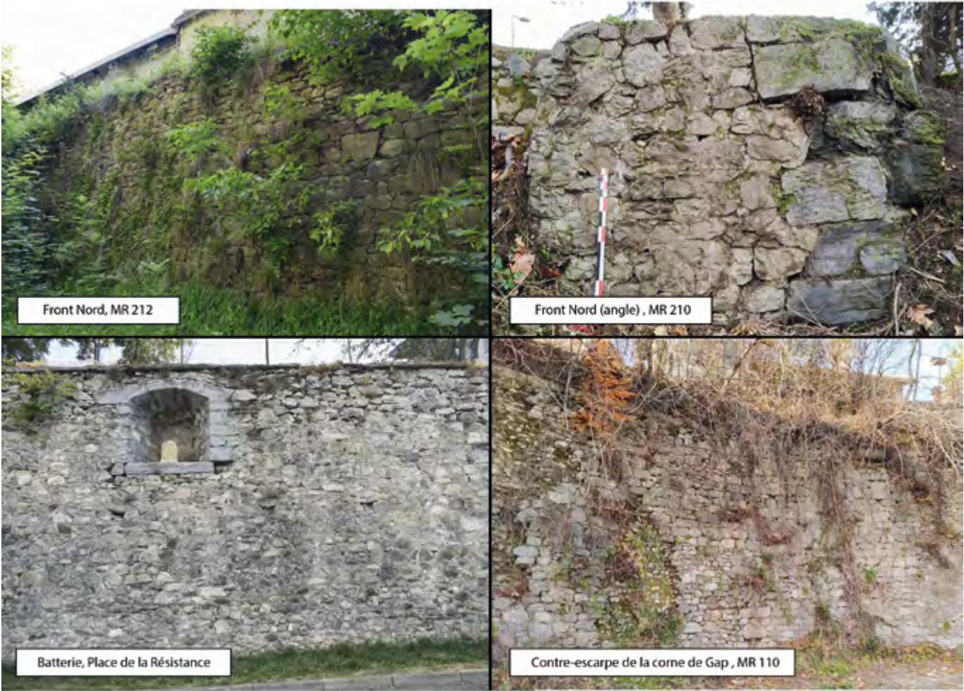
Fig. 28 – EMBRUN, Porte de Gap, parking des Remparts. Fortifications de l'entrée ouest d'Embrun (B. Vappereau/Inrap).
