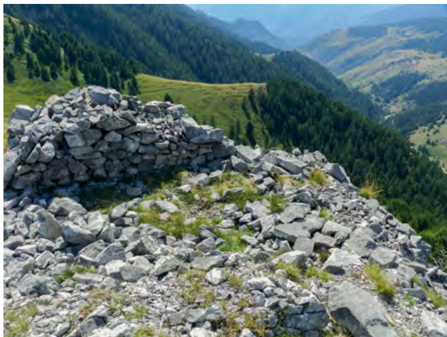
Fig. 32 – Val de Lantosque, commune de Belvédère. Détail du poste de couverture nord du col de Raus (à l'extrême gauche de l'image en contrebas). Au deuxième plan, emplacement de la grande redoute le protégeant, fermant l'accès depuis la Vésubie (cliché É. Gili).
