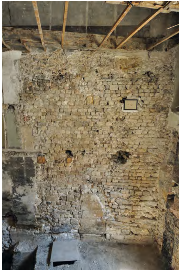
Fig. 68 – AIX-EN-PROVENCE, Hôtel Boyer d'Éguilles. Vue générale du parement médiéval englobé dans le mur mitoyen oriental de l'hôtel particulier (cliché É. Rey/DAMVA).
