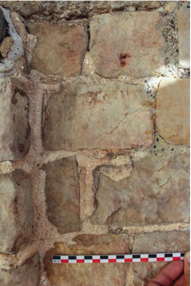
Fig. 178 – ORANGE, Mur Pontillac. Vue des vestiges de joints saillants, façade ouest (cliché J. Taulier).
