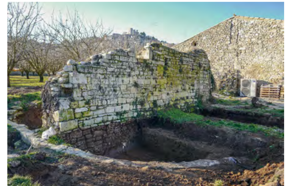
Fig. 163 – LACOSTE, Maison-Basse. Photographie de la face est du mur 1 et des fondations (cliché P. De Michèle, infographie P. De Michèle/SADV).
