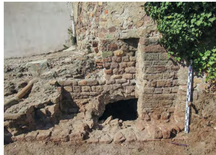
Fig. 116 – FRÉJUS, Rue des Moulins. Vestige d'arc délimitant l'ouverture d'une des salles, englobé dans une niche du nymphée des thermes (cliché S. Ardisson/SAPVF).
