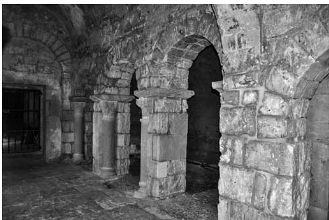
Fig. 109 – ARLES, ermitage Saint-Pierre de Montmajour. Vue de l'arcature séparant les deux églises après les travaux (L. Deye / Hadès).
