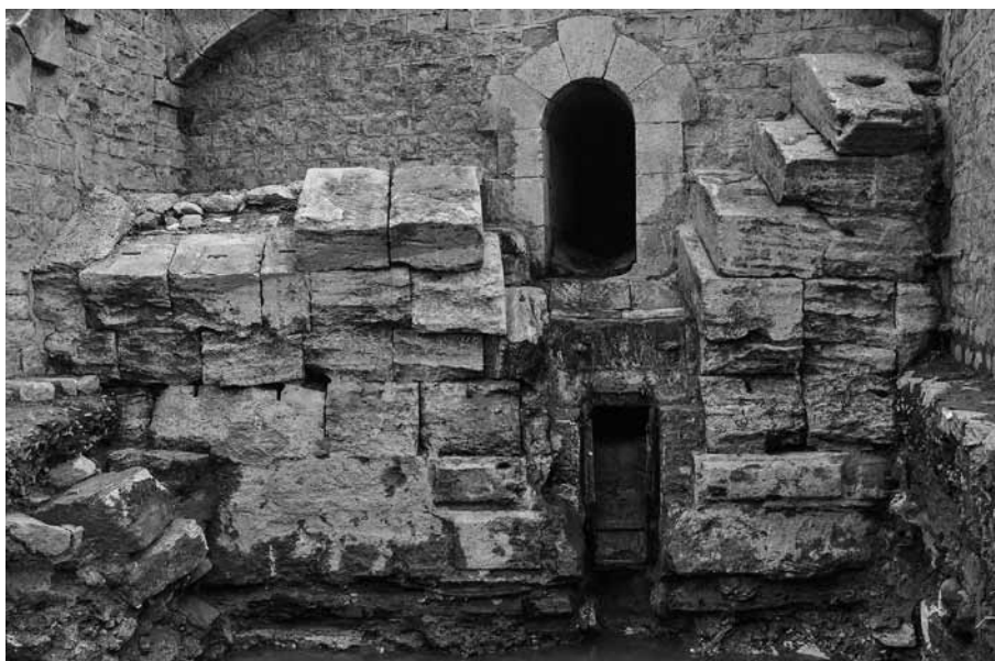
Fig. 110 – ARLES, quai Marx Dormoy. Vue frontale des vestiges du pont antique depuis le fleuve (cliché Ph. Mellinand / Inrap).
