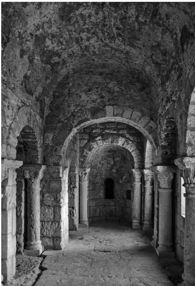
Fig. 108 – ARLES, ermitage Saint-Pierre de Montmajour. Vue générale de l'église sud après les travaux (L. Deye / Hadès).
