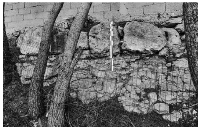
Fig. 137 – MARTIGUES, Tamaris. Parement externe du rempart nord de l'habitat gaulois, VI e s. av. J.-C. (cliché J. Chausserie-Laprée / SAVM).
