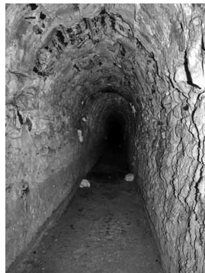
Fig. 91 – AIX-EN-PROVENCE, 19 chemin Saint-Donat. Vue de l'intérieur de l'aqueduc (cliché A. Bouquet / SAVN).
