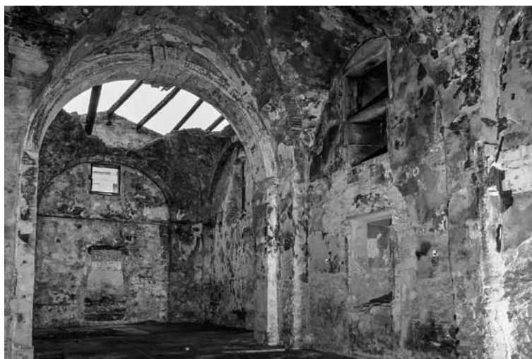
Fig. 128 – MARSEILLE, chapelle de la Capelette. L'intérieur de la chapelle, après deux incendies, juste avant la démolition (cliché B. Sillano / Inrap).
