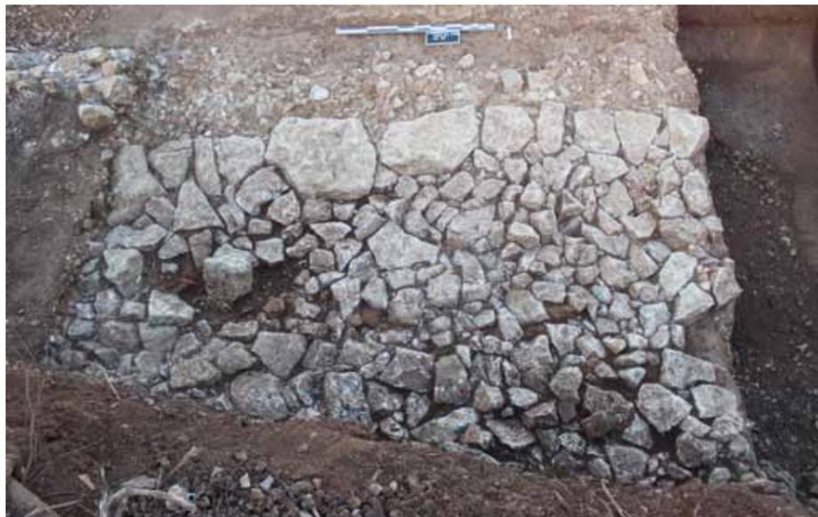
Fig. 151 – DRAGUIGNAN, Le Fournas. Radier de voie VO 30 au sud du mur de clôture de la ferme (cliché B. Jossier/SDA Var).
