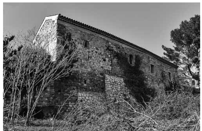
Fig. 21 – Volx, le château. Façade est, vue vers le nord-ouest (cliché M. Vivas / SDA-04).
