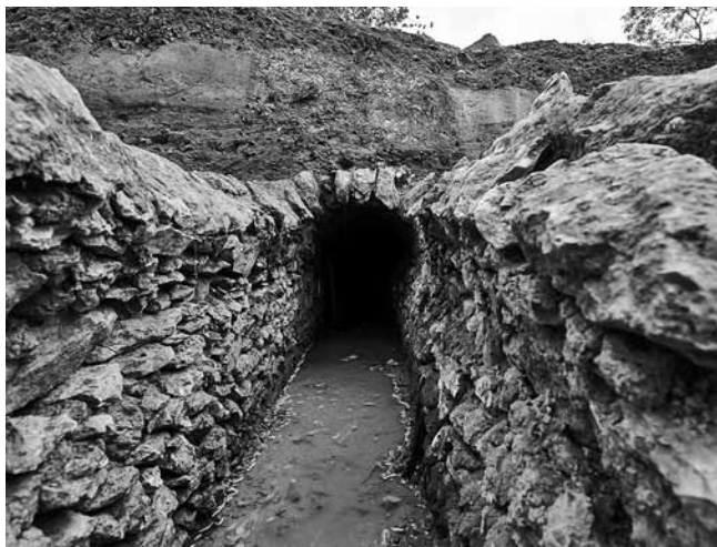
Fig. 120 – MARTIGUES, 10 avenue Paul Di Lorto. Vue prise depuis l'est du mode de construction en pierres sèches des parois et de la voûte de l'aqueduc repéré dans la tranchée 6, à l'extrémité est du terrain (cliché H. Marino / SAVM).
