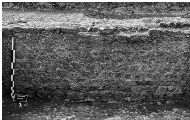
Fig. 97 – AUBAGNE, chemin de la Louve. Élévation septentrionale du mur bordier de la voie (cliché S. Scalisi / Inrap).
