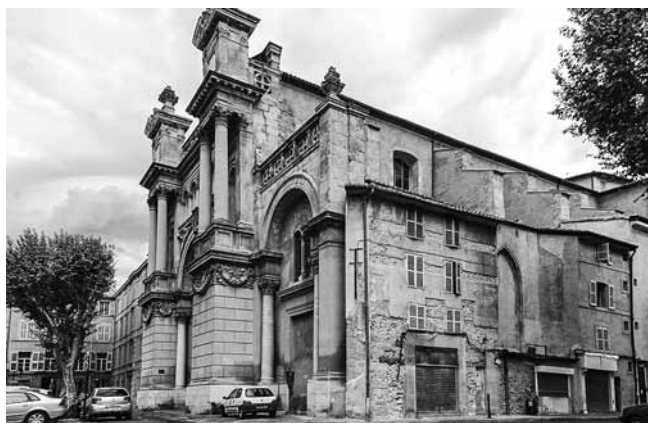
Fig. 72 – AIX-EN-PROVENCE, place des Prêcheurs, bâtiments adossés à l'église de la Madeleine. Vue générale de l'église de la Madeleine et des bâtiments adossés, prise depuis le sud-ouest (cliché E. Rossetti o Roscetti / DAVA).
