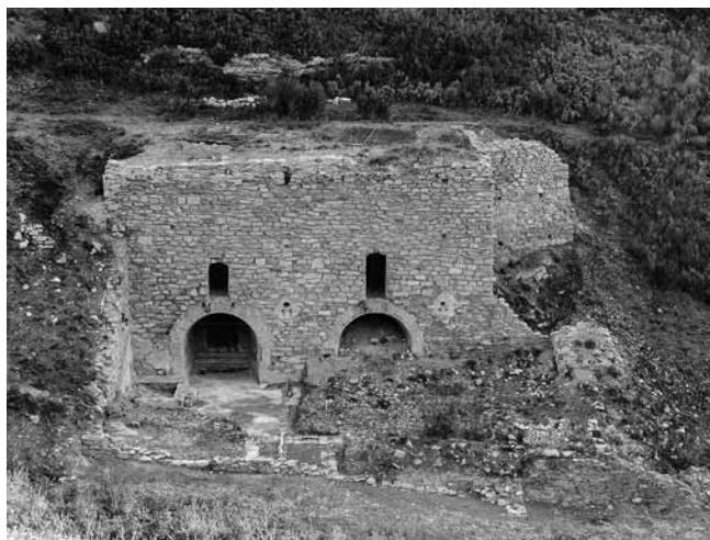
Fig. 112 – MARSEILLE, Vallon de la Panouse. Vue du four à chaux (cliché A.-M. D'Ovidio / DA-SMPH-Marseille).
