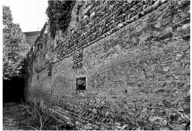
Fig. 212 – LE THOR, territoire communal. Partie d'enceinte médiévale où figurent distinctement deux états de construction (cliché N. Duverger / DPI).
