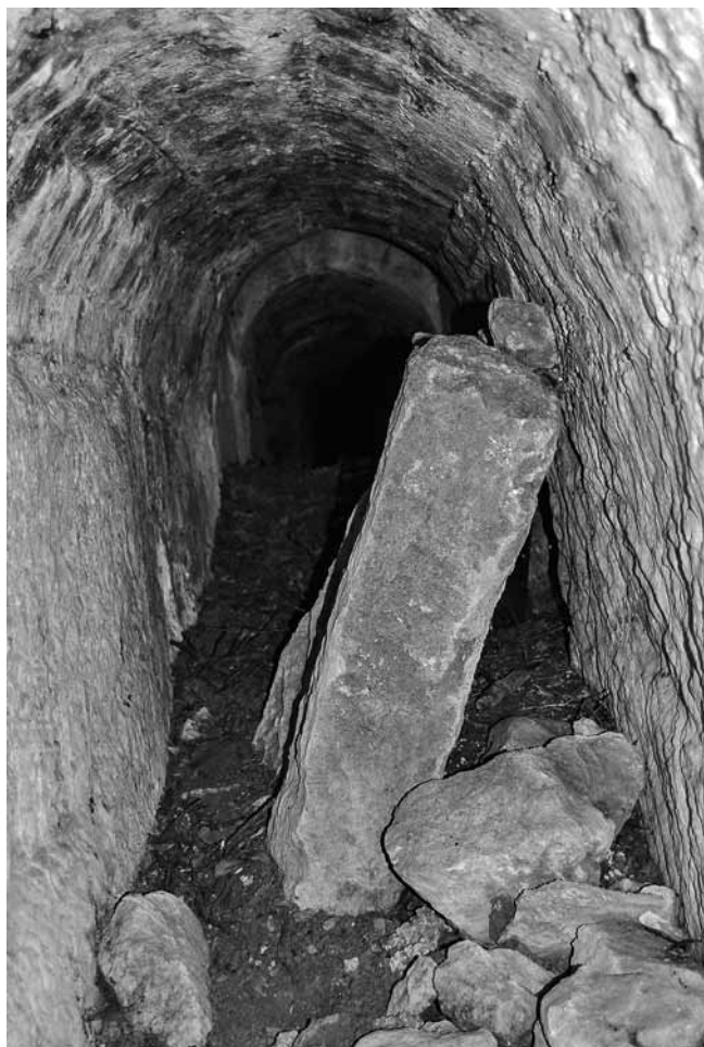
Fig. 147 – L'aqueduc romain de Traconnade. Dalle de fermeture tombée dans un regard à Peyrolles (inv. n°. 82 au PK 6,5) (cliché B. Fino).
