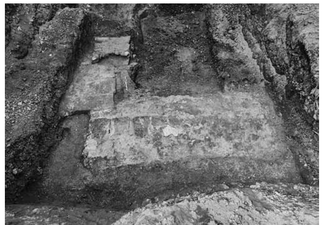
Fig. 109 – MARSEILLE, 165 rue Sainte / rue du Commandant Lamy. Les fondations du rempart défensif de l'abbaye et le mur antérieur depuis l'est (cliché B. Sillano / Inrap).
