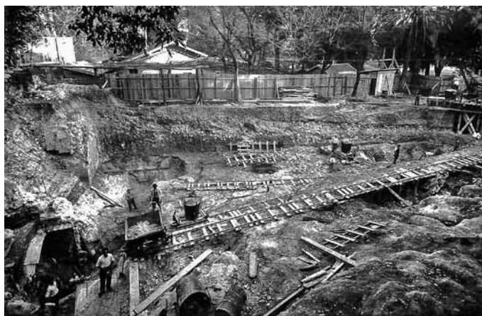
Fig. 36 – PCR « colline du château ». Vue du chantier de construction du bassin inférieur de la colline du Château (4 janvier 1937).
