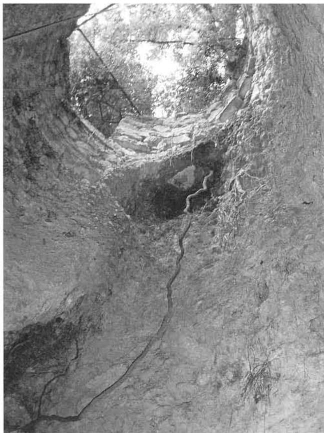
Fig. 64 – Roquefort-les-Pins, puits de l'aire de Boule. Partie supérieure du puits : seul le sommet est maçonné (cliché S. Fulconis).
