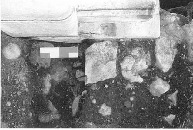
Fig. 32 – LE GLAIZIL, château de Lesdiguières. Vue de dessus : le socle en ressaut sur le fossé et sa face intérieure perpendiculaire à la feuillure ; on distingue la crapaudine horizontale (cliché P. Boucard).
