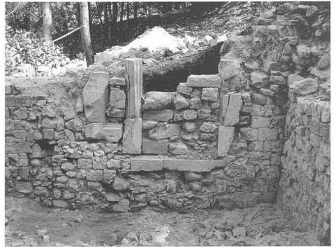
Fig. 34 – Mur M3, bien appareillé, à gauche, et fenêtre F1, comblée, à droite (cliché N. Nicolas).
