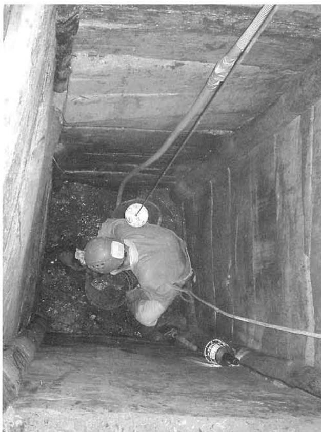
Fig. 6 – TARTONNE, puits salé de la Salaou. Cuvelage interne (D. Morin).
