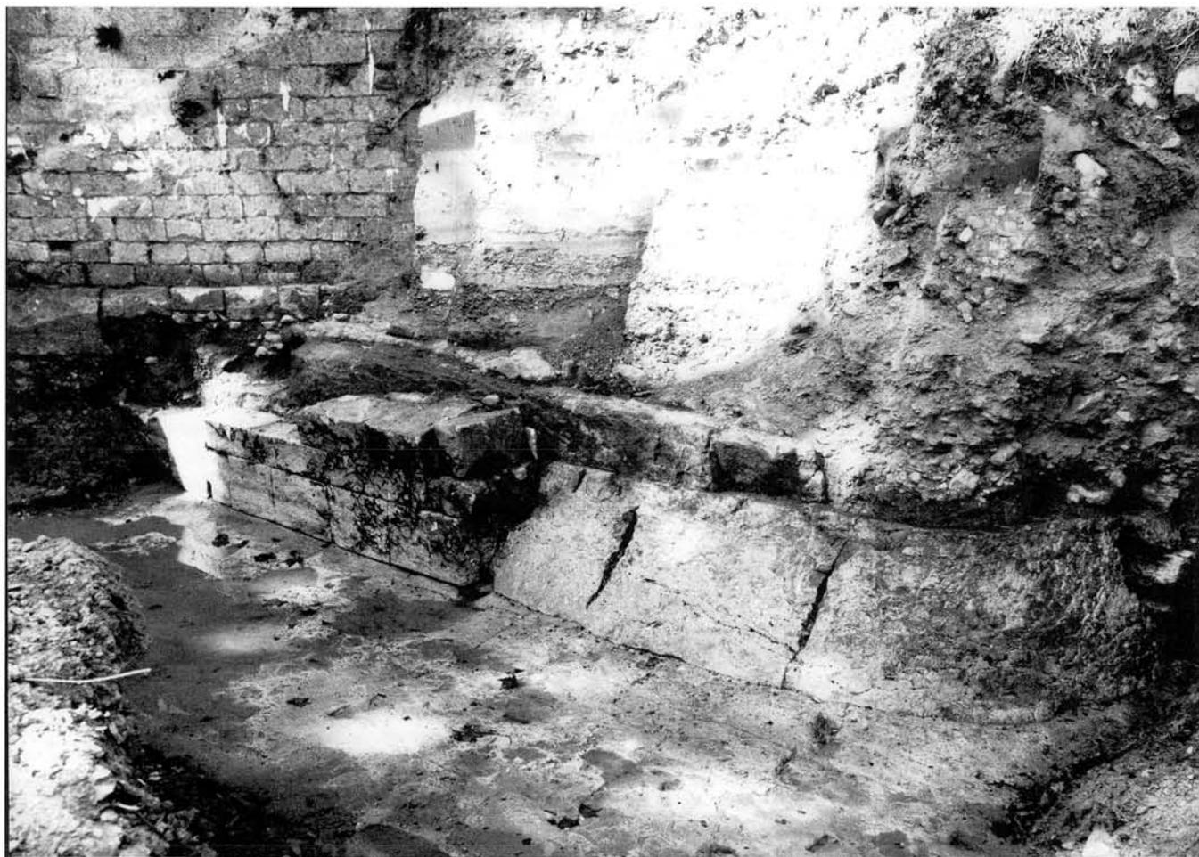
Fig. 6 — CÉRESTE, pont de l'Aiguebelle. Vue de la culée occidentale posée sur la semelle filante de grand appareil. La partie restaurée en moyen appareil à l'époque moderne n'est conservée que dans sa moitié sud. À l'arrière-plan, la culée du pont contemporain (J.-L. Paillet).
