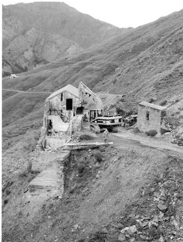
Fig. 24 — SAINT-VÉRAN, Mine de cuivre des Clausis. Mise en sécurité du logement des ouvriers et de la cantine : avant, pendant et après les travaux (Actilia Multimedia).
