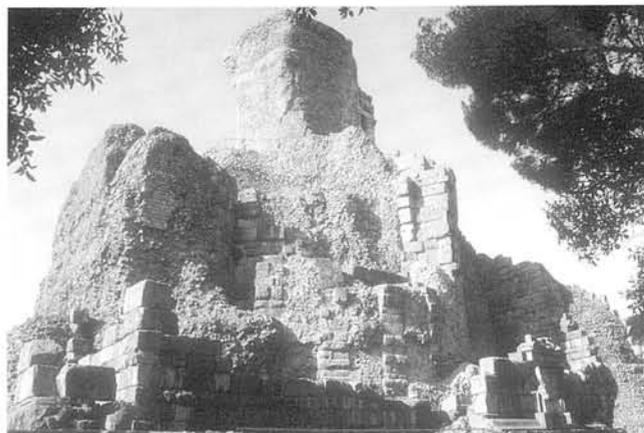
Fig. 37 — LA TURBIE, trophée d'Auguste. La structure interne du monument vue côté nord : imbrication de grand appareil et de blocage (S. Binninger).
