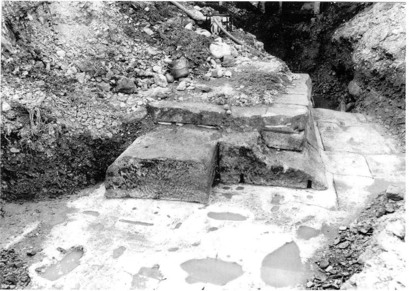
Fig. 7 — CÉRESTE, pont de l'Aiguebelle. Vue du nord vers le sud de l'unique pile centrale. Elle repose sur une semelle filante constituée de blocs de grand appareil reliés entre eux par des agrafes en  $\pi$  scellées au plomb. L'assise supérieure de la pile correspond à la restauration moderne (J.-L. Paillet).
