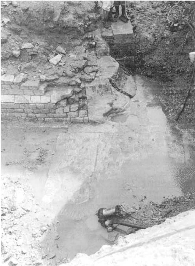
le parement nord de la culée, qui se poursuit suivant une élévation de petit appareil régulier et soigneusement assisé, et reconnaître le niveau de sortie de fondation et celui de la construction antique (assise
