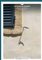
02 les finitions d'enduit
