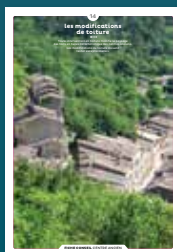
14 les modifications de toiture
