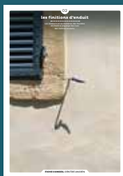
02 les finitions d'enduit
