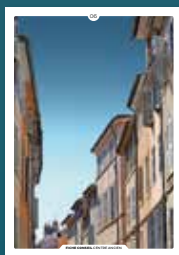
06 les débords de toitures
