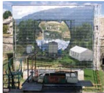
Armas) pour démontrer l'intérêt du mur capteur-accumulateur de chaleur dit « mur Trombe » dans l'architecture domestique. La réalisation architecturale terminée en 1974 a été l'œuvre d'un architecte parisien Jacques Michel, spécialisé dans le solaire. Il s'agit d'un petit collectif de trois logements indépendants mais solidaires, qui a valeur de première démonstration en France du système de solaire passif.
