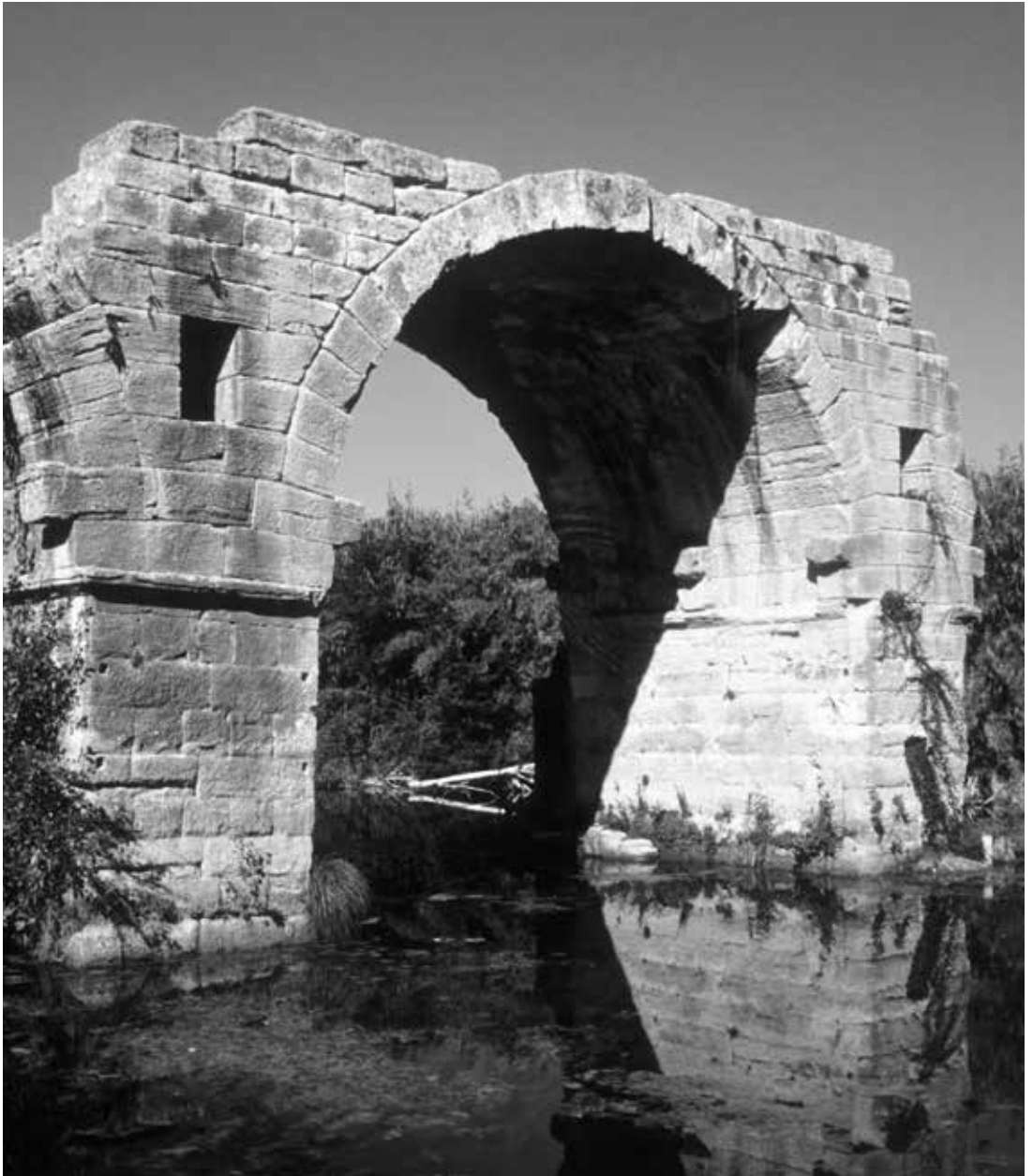
Gallargue-le-Montueux (30)/Villetelle (34), pont d'Ambrussum. Pages précédentes : Vers-Pont-du-Gard (30), pont du Gard.
