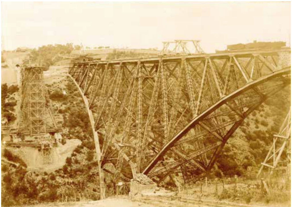
Viaduc du Viaur (81-12) : les différentes étapes de la construction.
