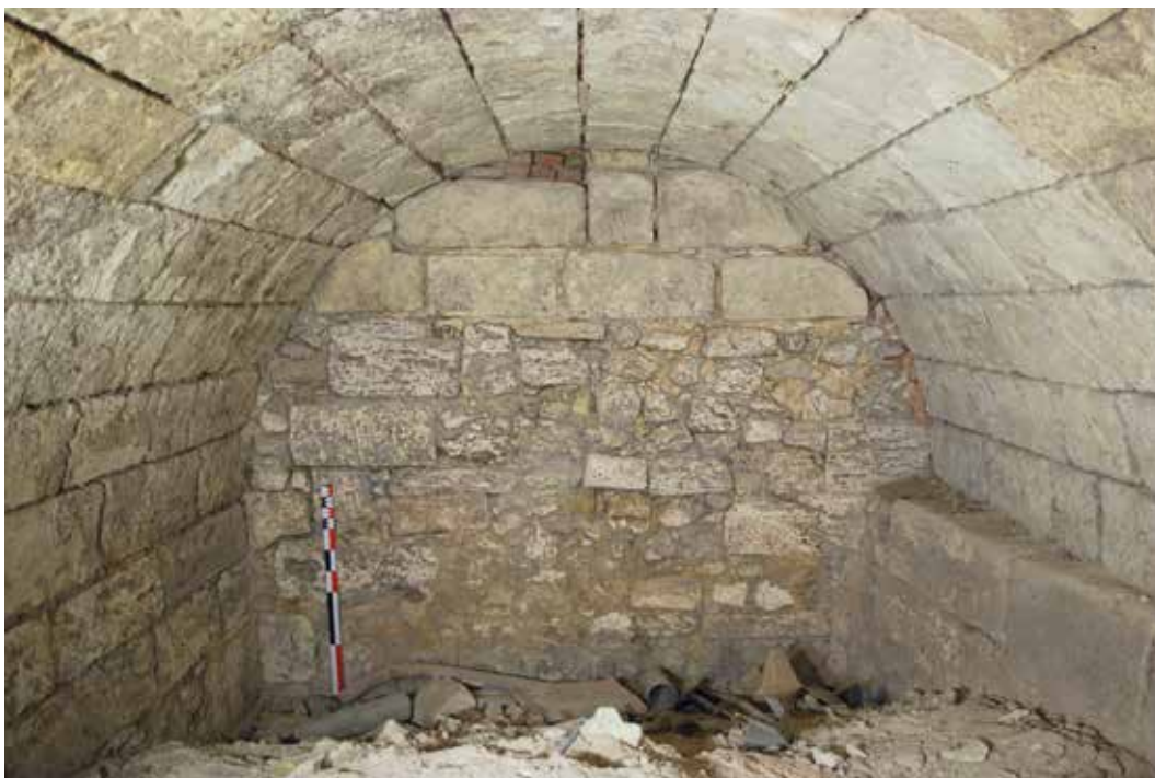
Blois, le Château, la salle voûtée de la fosse latrine sous l'escalier Louis XII (Pièce L.S. 00.04). Vue générale du mur ouest prise depuis l'est (éch. 1 m). Noter les deux dernières assises en pierre de tuffeau, taillées pour se conformer au profil de la voûte (S. Bryant, Inrap).
