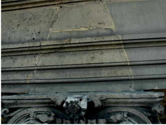
**Fig. 05 :** Détail d'un des chapiteaux de l'étage. La dégradation est liée à la présence de métal. Noter également la différence d'aspect des parements pierre et ragrésés (cl. MO).
