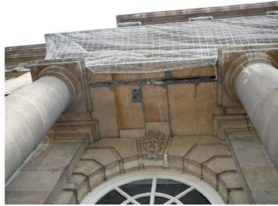
**Fig. 06 :** la saignée de couleur différente à l'intrados de la baie laisse deviner l'insertion d'une armature métallique dans les claveaux de l'arc (cl.ACMH).
