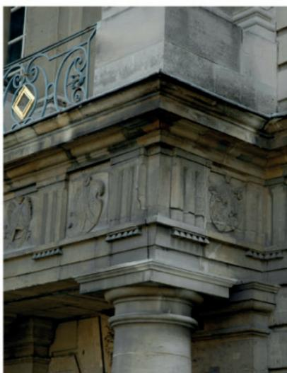
**Fig. 03** : angle Sud de l'entablement du r.d.c. avant la pose des filets. D'importantes fissures sont visibles dans l'architrave, horizontales et verticales (cl. MO).
