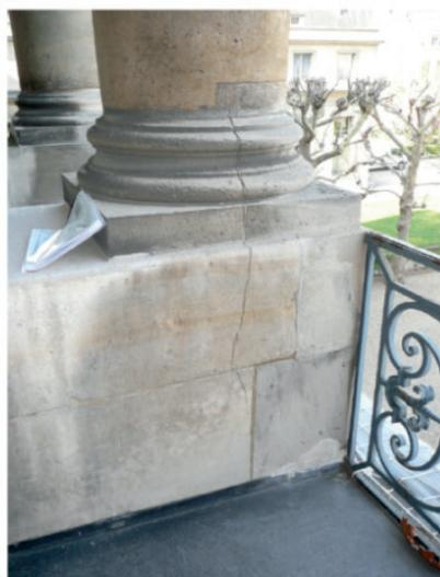
**Fig. 04** : soubassement et base de la 3e colonne de l'étage. Détail de la fissure côté Nord (cl. ACMH).
