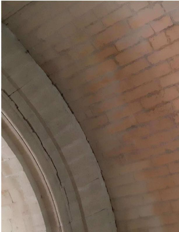
Déformation de l'arc. Rupture entre claveau et décollement au droit de la voûte de la nef
