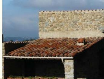
Sur les toitures à 1 pente, le faitage est réalisé en scellant le dernier rang de tuiles sans débord et sans rapporter de tuiles faitières.
