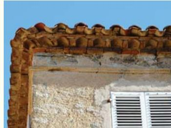
Génoises constituées de tuiles, associées ou non à des carreaux de terre cuite et recouvertes parfois d'un rang d'ardoises.
