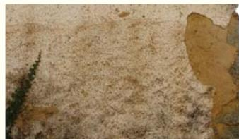
Enduit de tuf à Pioggiola recouvert d'un lait de chaux blanc.
