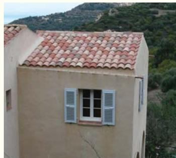
Gouttières «à la balanine» : chéneau bâti en tuiles sur le mur. Il s'évacue par une gargouille ou une descente en éléments de terre cuite
