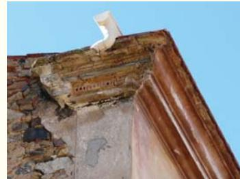
Corniches moulurées réalisées au mortier chaux-pierre lissé au gabarit
