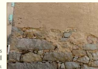
L'enduit à pierres vues est le résultat d'une dégradation de la surface de l'enduit. Cependant cet aspect peut être recherché lors des réfections de l'enduit des façades secondaires et des pignons
