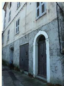
Les mortiers de rejointoiement réalisés au ciment empêchent l'assèchement des murs.
