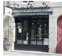
Enseigne bandeau lettres découpées fixée directement sur la façade
