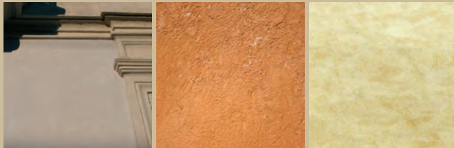
enduit finition lissée très fin à la truelle
