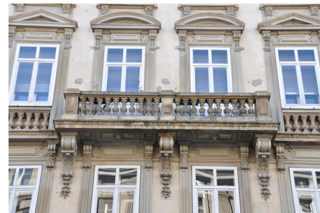
Doubles menuiseries extérieures d'origine sur un immeuble de la Neustadt. Leur dessin à traverse et imposte respecte celui de la menuiserie intérieure © Région Grand-Est - Inventaire général
