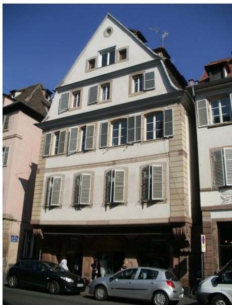
Façade du XVIII e siècle : valeur de typologie architecturale, génie constructif, de d'ancienneté, d'authenticité et d'intégrité © Bailly-Leblanc
