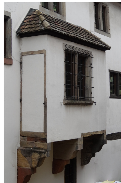
Ouvrage en surplomb début Renaissance : valeur de rareté, d'ancienneté et de génie constructif © Bailly-Leblanc
