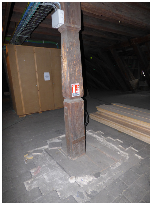
Comble à poteaux, plancher bois protégé par un dallage de terre cuite © Atelier G. André
