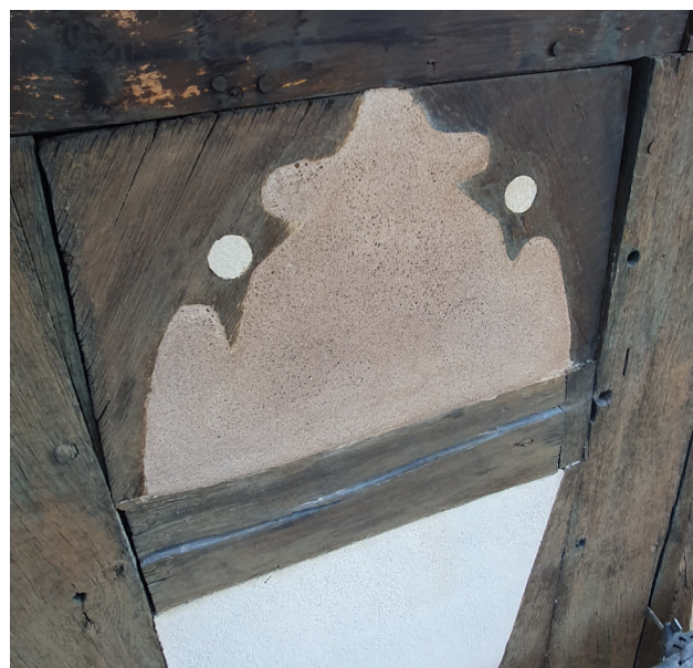
Echantillon d'enduit au mortier de chaux en remplacement de l'enduit hydraulique © Atelier G. André
