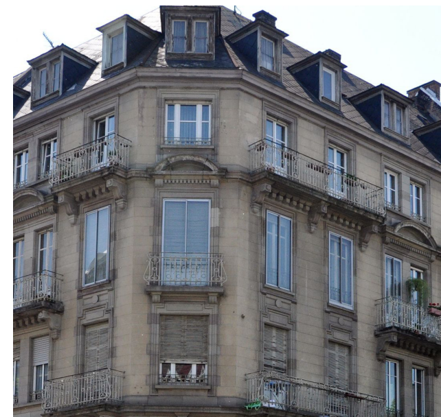
Les doubles menuiseries ont été remplacées par des châssis coulissants en aluminium (peu isolant) avec un dessin différent de celui d'origine © Région Grand-Est - Inventaire général
