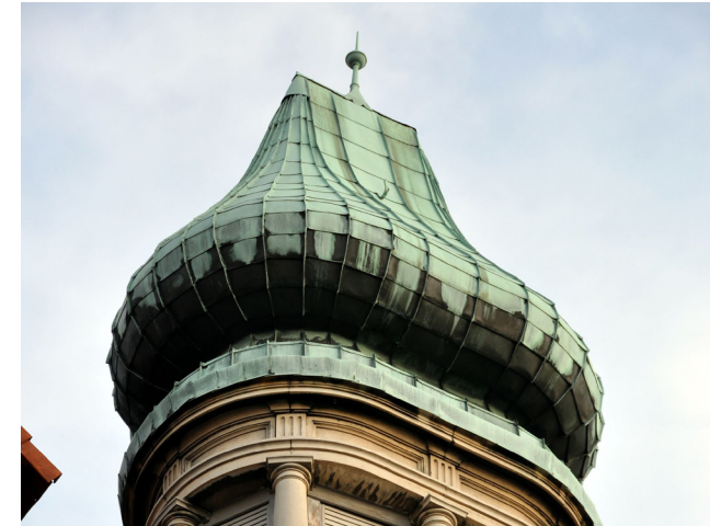
Couverture en tables de cuivre sur une toiture en bulbe dans la Neustadt, fin du XIX e siècle © Région Grand-Est - Inventaire général
