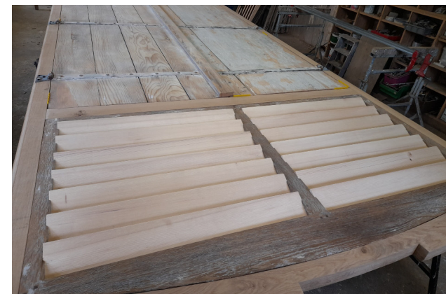
Volet en partie persienné en restauration - fin du XVIII e siècle © Atelier G. André
