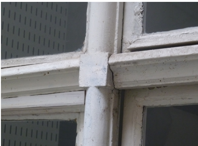
Détail d'une croisée de traverse du XVII e siècle dont le profil de traverse a pour but de protéger les ouvrants inférieurs des ruissellements d'eau de pluie © Bailly-Leblanc
