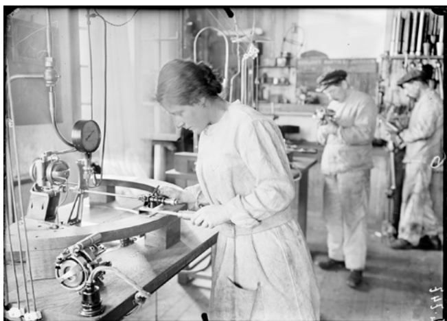
Arsenal de Cherbourg, un ban de réglage par gyroscope à air, mai 1916 © Albert Samama-Chikli / ECPAD / Défense
