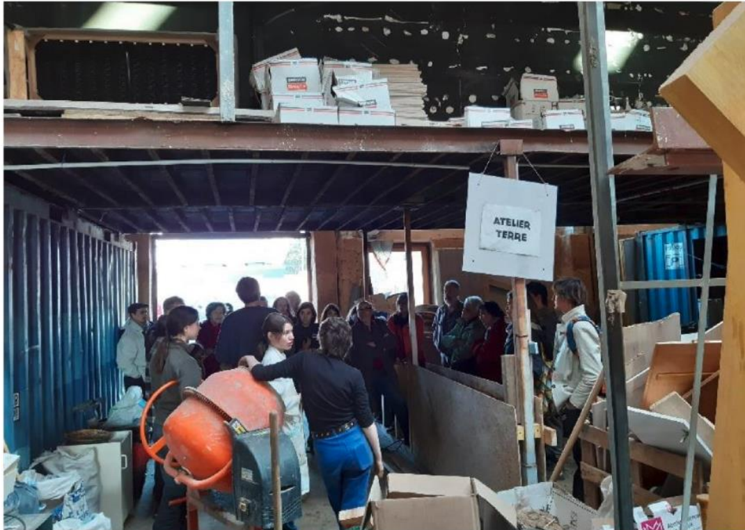
Figure 4 : Chantier participatif au Hangar Zéro. Atelier Terre.
