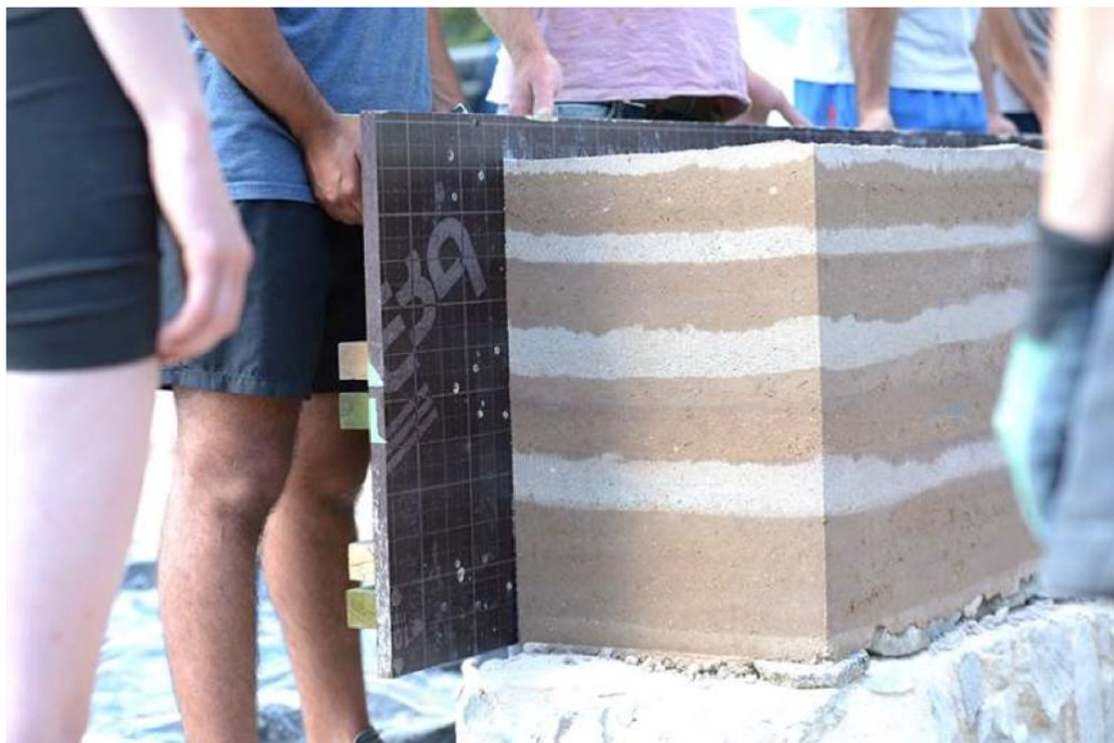
Figure 4 : Construction collective du prototype « Plateforme Rurapolis », Egulbati, 2022.
