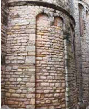
Fig. 1 - Absidiole sud au chevet avec motif d'arcatures aveugles dites en « bande lombarde ».
