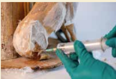
Fig. 5 - Consolidation des bois ver- moulus par injections à la seringue.
