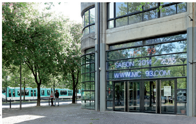
MC 93 — Scène Nationale. La Maison de la Culture 93 a fermé ses portes pour rénovation jusqu'à fin 2016 — Bobigny
