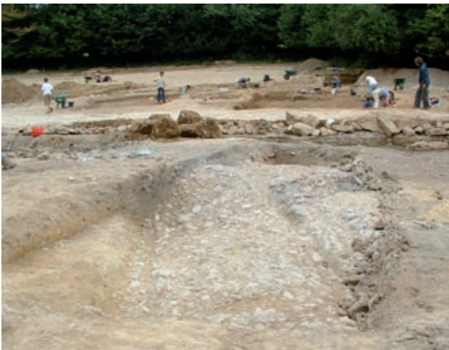
Fig. 9 : Montaigu-la-Brisette, Manche. Détails de la voirie avec sa chaussée en galets et fragments de tuiles, lacérée par des ornières. Photo. L. Jeanne.
