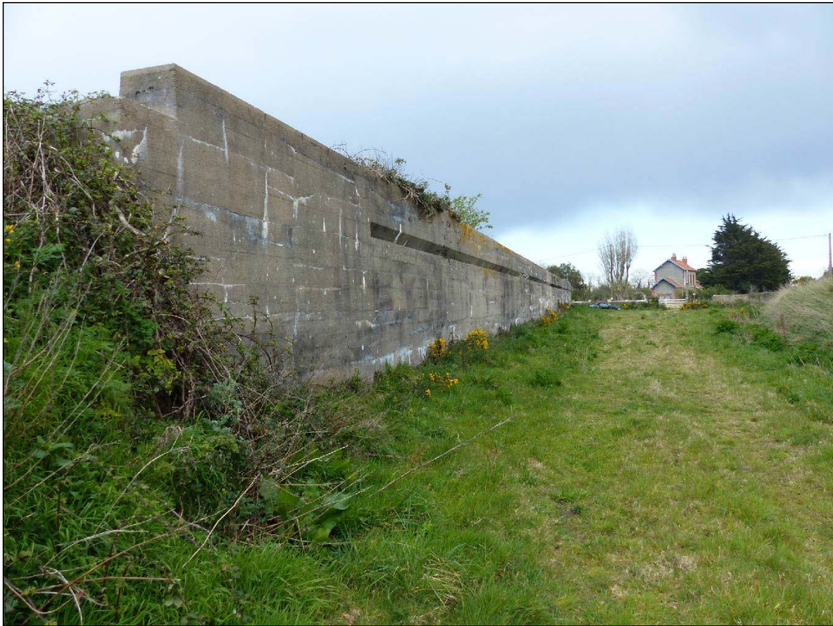
Fig. 78 - GATTEVILLE-LE-PHARE (50). Quai de chargement de sable (cliché C. Billard, SRA).
