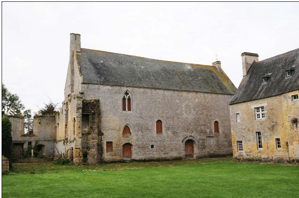
Fig. 75 - LONGUES-SUR-MER (14), ancienne abbaye Sainte-Marie. Vue du « réfectoire » depuis le nord-est (cliché M. Gardeux).
