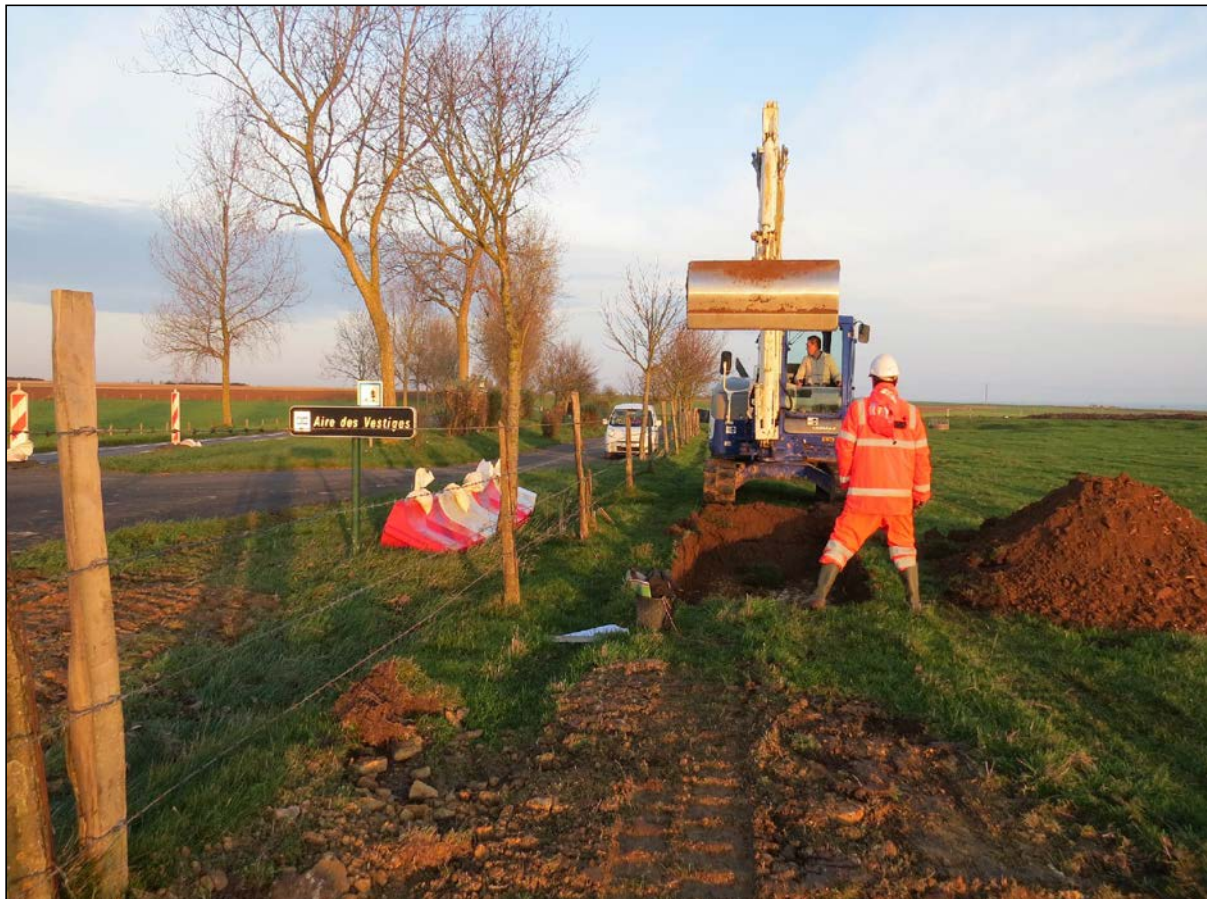
Fig. 36 - COURSEULLES-SUR-MER, raccordement électrique.
