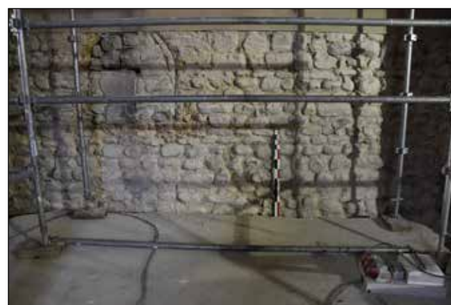
Fig. 1 Échantillonnage du parement nord du mur gouttereau méridional. Crédit : L. Benoit (UAPB-Dep74).
