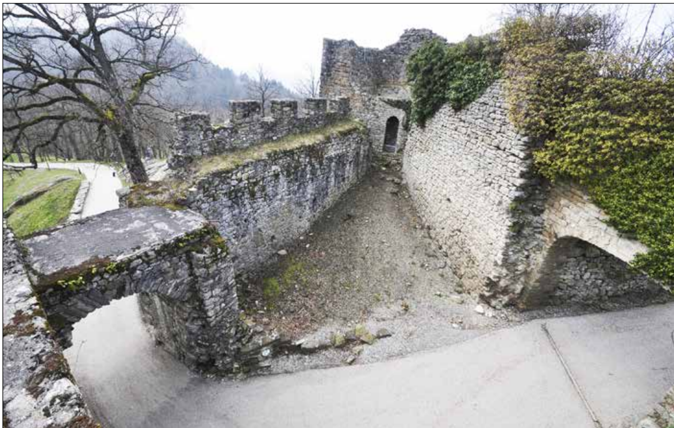
Fig. 1 Allinges (74), Château Neuf : l'intérieur de la barbancane sud-est. Crédits : L. D'Agostino, 2017.
