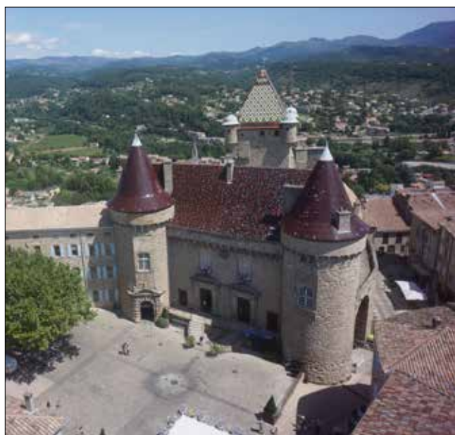
Fig. 1 Aubenas (07), château des Montlaur : vue aérienne. Crédits : Comair, 2017.
