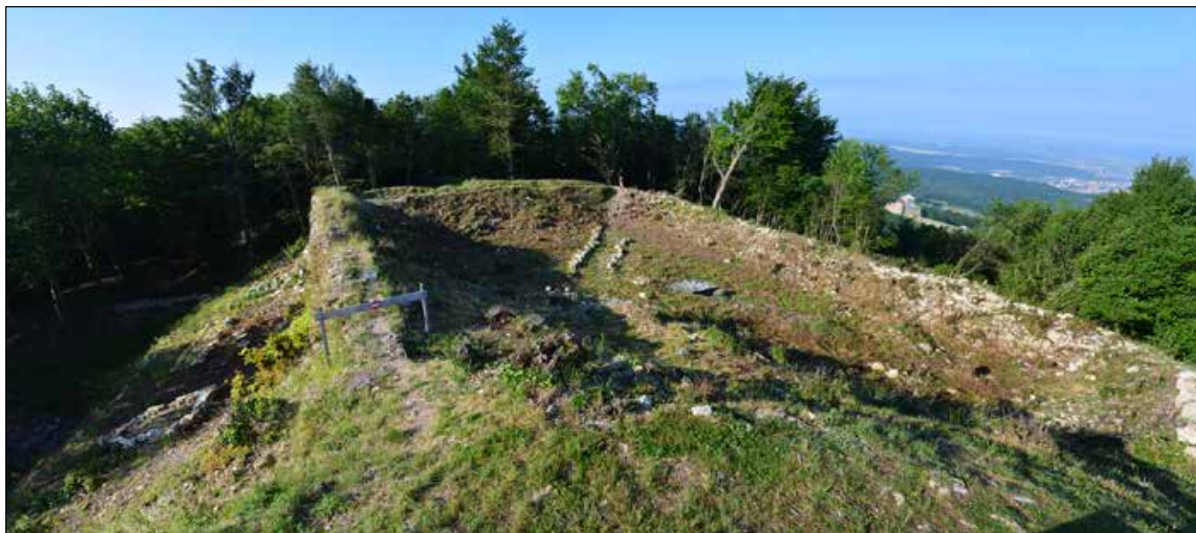
Fig. 2 Saint-Rambert-en-Bugey (Ain) : Cour centrale de la bâtie de Lusandre depuis la tour. Crédits : L. D'Agostino (AAA), 2017.
