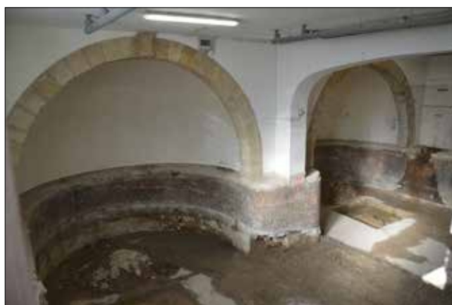
Fig. 1 Bourbon-l'Archambault (03), place des Thermes : sondages réalisés dans l'ancienne piscine. Crédits : G. Rocque (Sapda), 2017.
