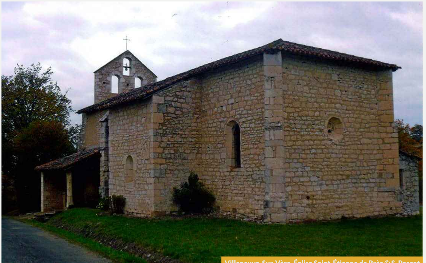
Villeneuve-sur-Vère. Église Saint-Étienne de Brès © S. Pascal
