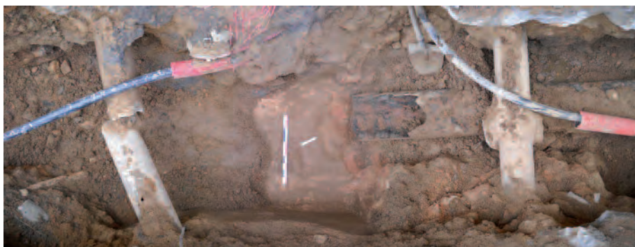
Poitiers, rue des Grandes Écoles, aqueduc de Basse Fontaine interrompu par une large maçonnerie (Cliché : L. Richard).
