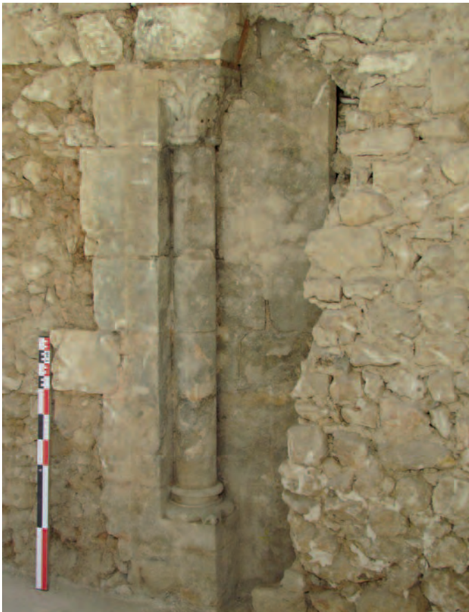
Poitiers, Saint-Jean-de-Montierneuf, piédroit extérieur de la baie de la deuxième travée du mur gouttereau sud de la nef de l'église (Cliché : X. Lhermite).
