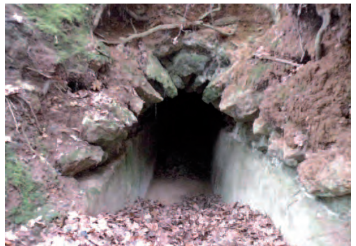
Figure 3a : Canal de l'aqueduc de Fleury (Béruges) (Cliché : C. Lambaré).
