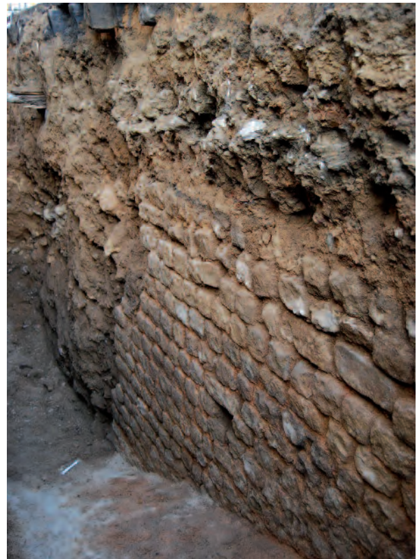
Poitiers, parement en petit appareil dans la tranchée au 14 rue du Petit Bonneveau (Cliché : C. Bélliard).
