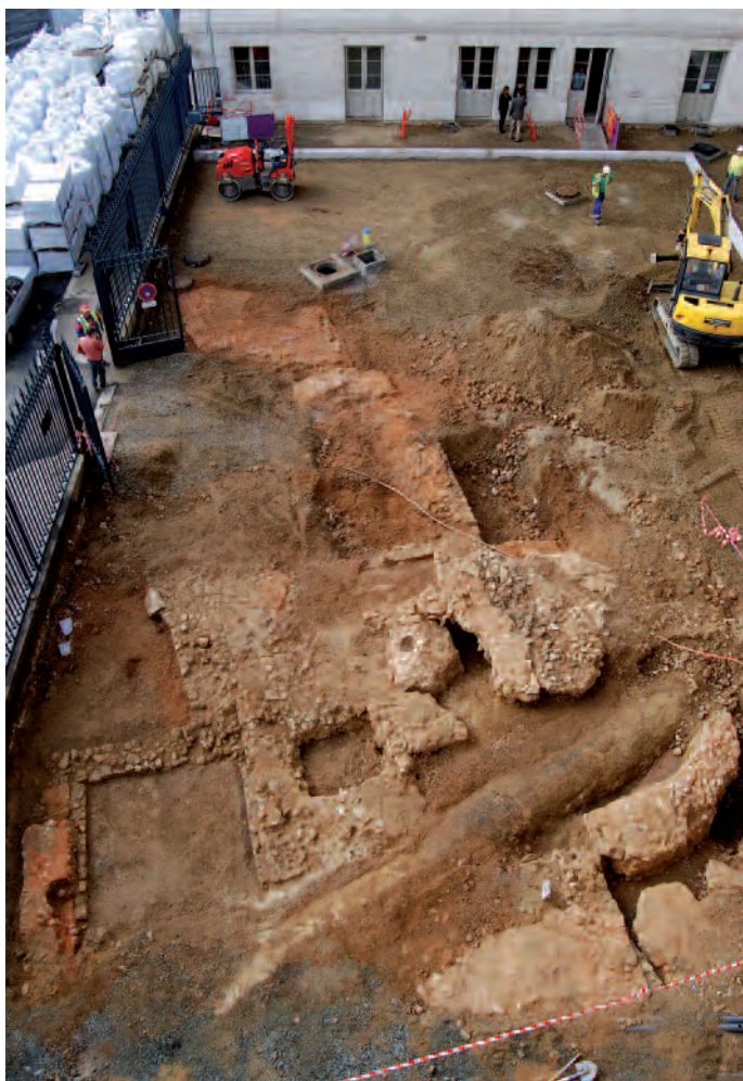
Poitiers, vue générale des vestiges dans la cour arrière de l'Hôtel de ville (Cliché : C. Bélliard).
