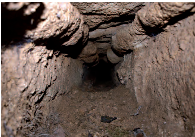
Aqueduc du Cimeau, épaisse couche de concrétion dans le conduit à la sortie du Castellum du Gué aux Rats (Cliché : P. Arbona).
