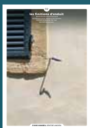
02 les finitions d'enduit
