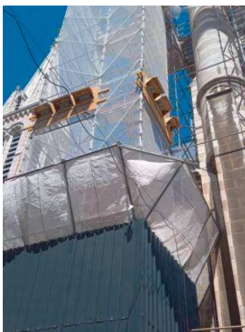
Nichoirs artificiels sur échafaudage © CRMH/DRAC PACA
