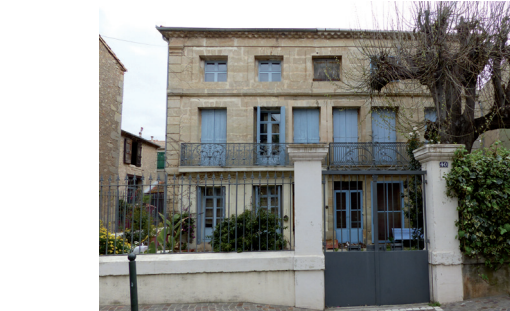
Façade en pierre de taille
