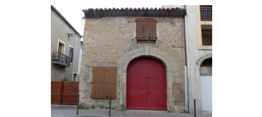
Ancienne remise agricole
