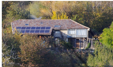
Panneaux solaires implantation en bande (Aizac)
