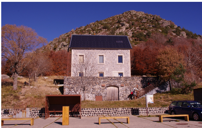
Toiture entièrement couverte de panneaux solaires (Maison de site du Gerbier de Jonc)
