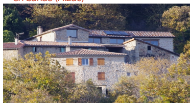
Panneaux solaires implantés en alignement avec un percement (Aizac)
