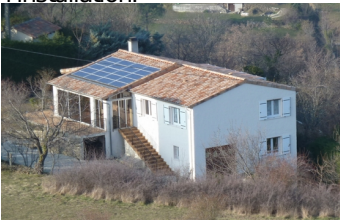
Panneaux solaires implantation en bande (Privas)
