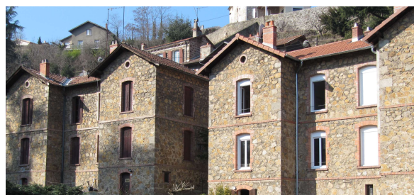
Toitures de bâtiment du XIXe siècle conçues pour des tuiles mécaniques plates (Annonay)
