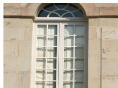
Pose de volets intérieurs
