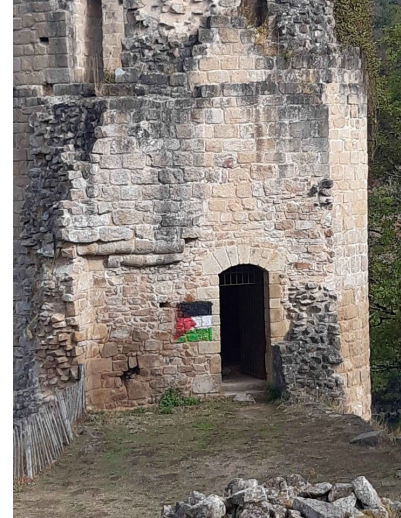
Figure 13 : Château de Crozant, DRAC Nouvelle-Aquitaine
