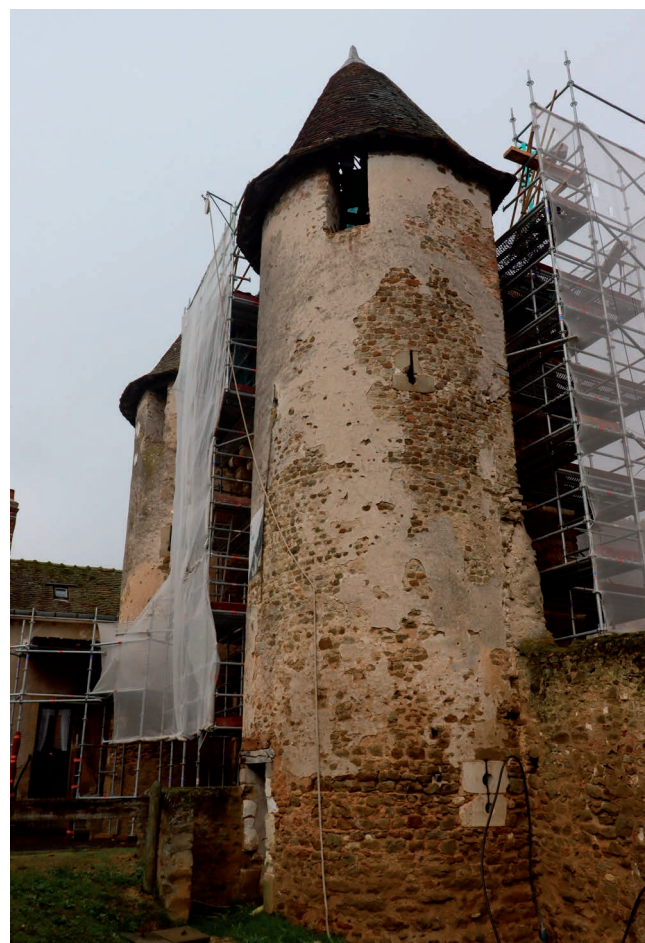
Levroux (Indre) Porte de Champagne : vue de la porte depuis le sud-est. (Pouyet, Inrap)
