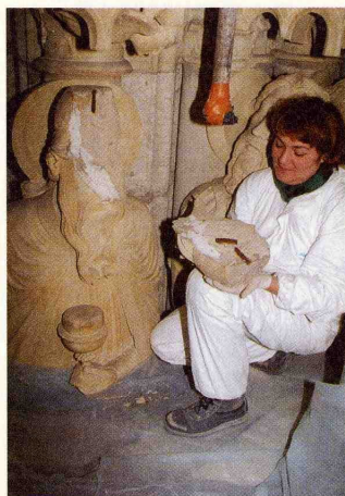
Dépôt d'un visage, pose d'un nouveau goujon inoxydable et collage
