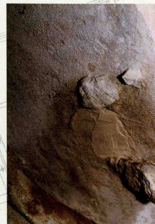
Vue d'un ragréage pour combler une lacune. Il sera ensuite gratté après séchage pour lui donner son relief définitif
