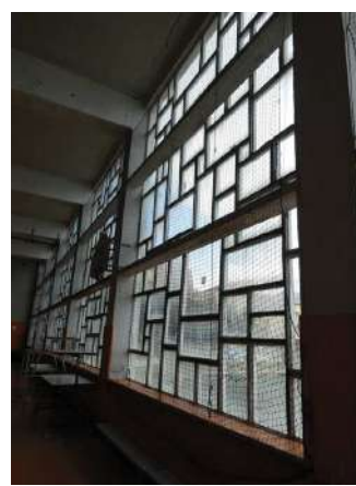
détail des claustras, intérieur
