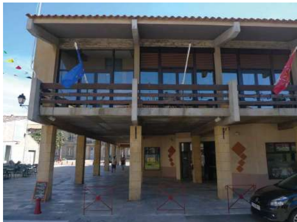
façade nord, pilotis, balcon de la salle polyvalente
