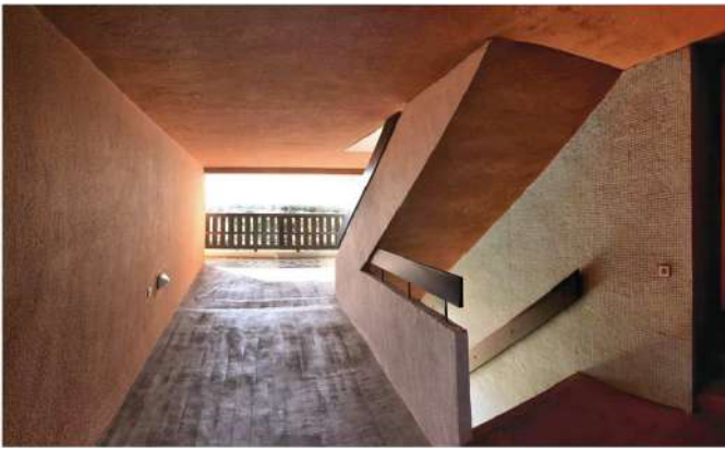
paliers ouverts sur la façade
