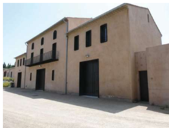
partie basse, bâtiments anciens réhabilités
