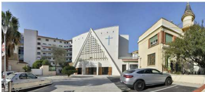
vue générale et parvis
