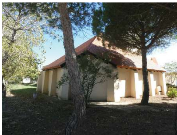
façade arrière, contreforts
