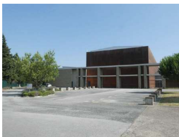
vue de l'entrée, silo des archives
