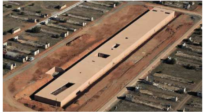
vue aérienne du bâtiment
