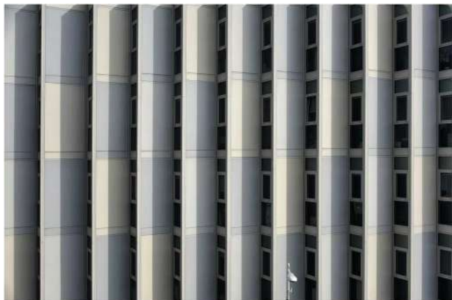
détail des refends de la façade
