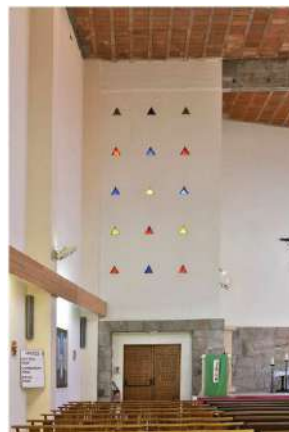
pavés de verre colorés, façade intérieure ouest
