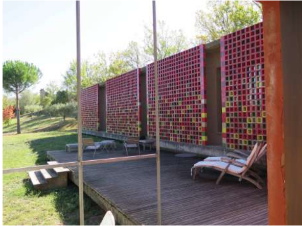
Vue générale de la façade, côté terrasse
