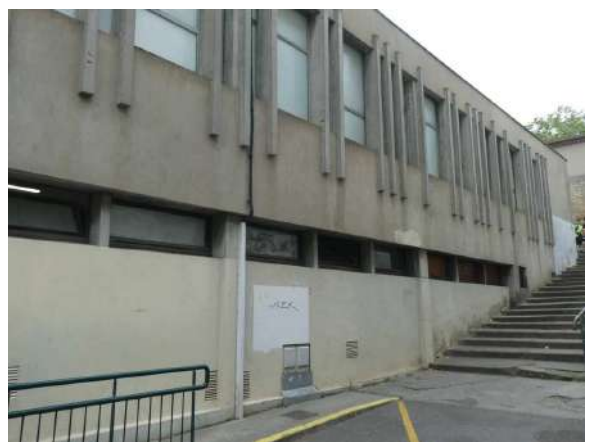
façade nord, escalier vers la rue des Etudes
