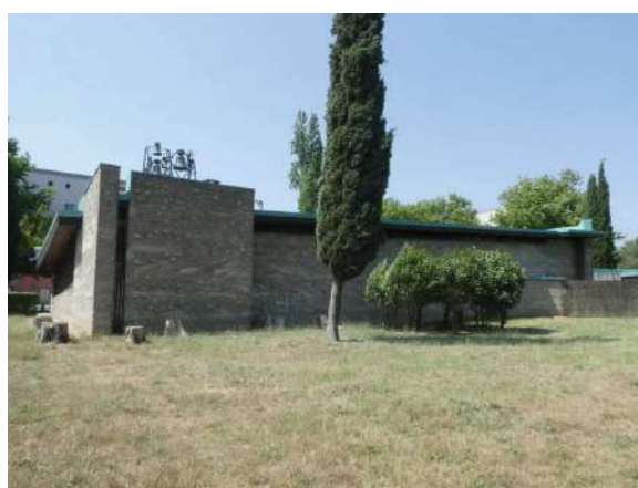
vue générale, façade nord
