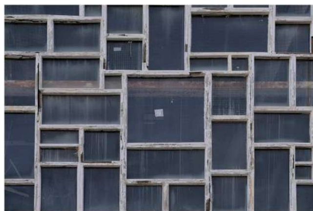
détail des claustras, extérieur
