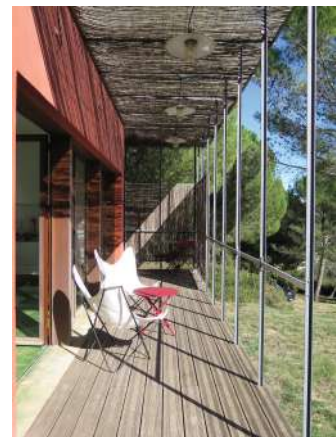
terrasse recouverte de brise-soleil en osier
