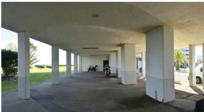
rez-de-chaussée sur pilotis
