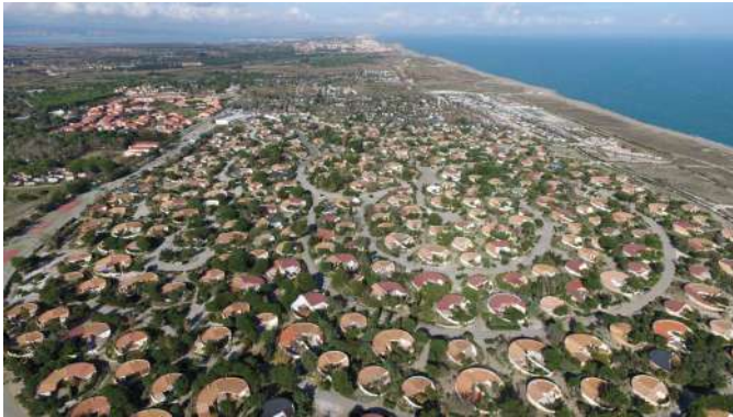
vue aérienne du site
