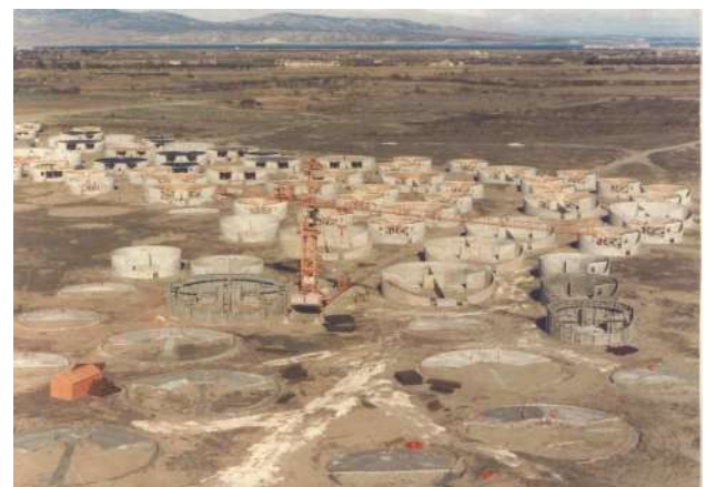
site en construction
