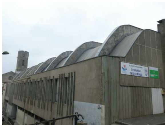
vue générale depuis la rue des Etudes
