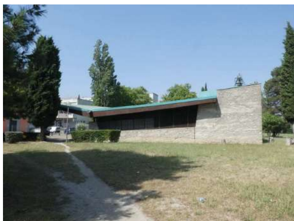
vue générale côté est
