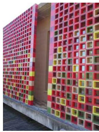
détail de la peau en briques de céramique
