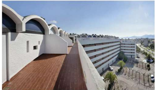
vue des terrasses-promenade du toit
